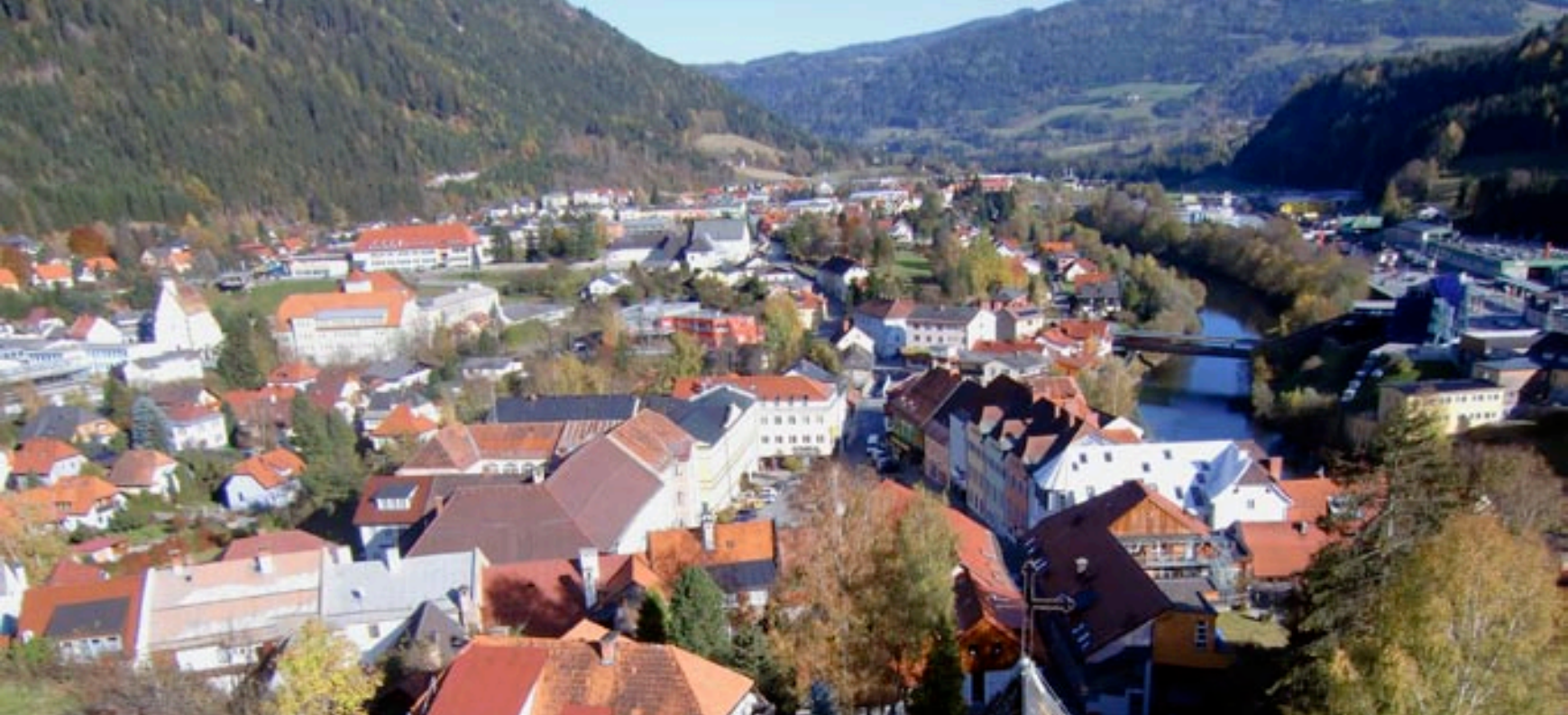
Abb 43: Projektgebiet und Schillerplatz vom Glockenturm der Matthäuskirche aus gesehen.
