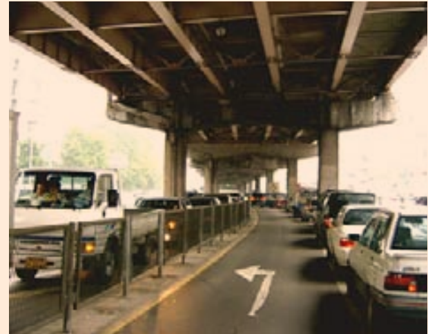
Abb 31: Stau unter der aufgeständerten Schnellstraße [B15]
