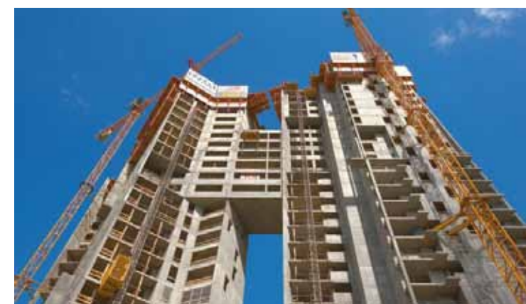
039 Stahlbetonkonstruktion im Bau [ © http://ii.forum.mojeosiedle.pl ]
