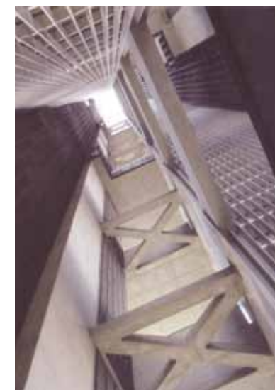
082 horizontale Betonkreuze zwischen den Türmen [© DBZ 7|2011, 29.]
