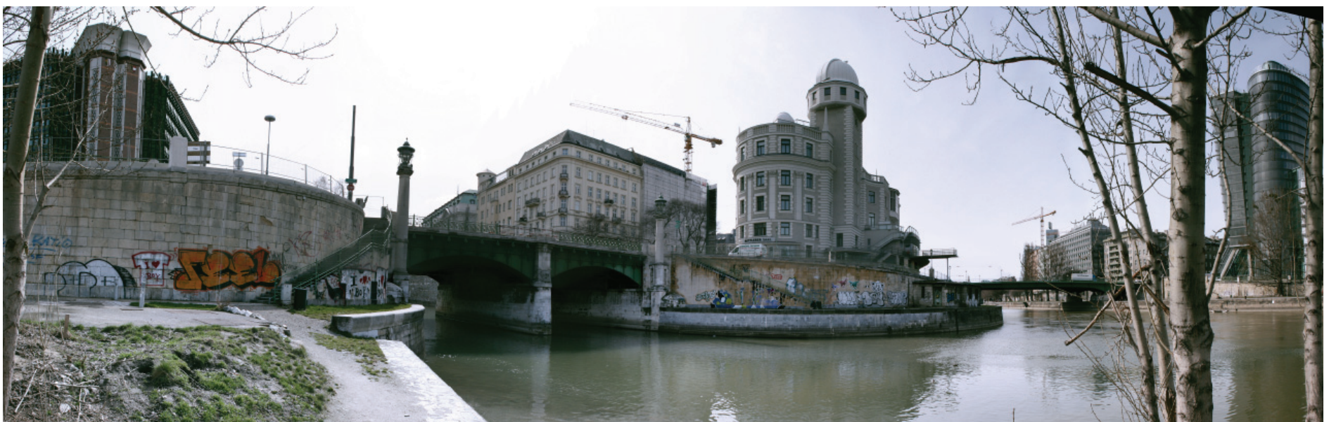
Abbildung 68: Unmittelbare Entwurfsumgebung. Linker Bildrand - Hermannpark; Linke Bildmitte - Radetzkybrücke; Rechte Bildmitte - Urania; Rechts neben der Urania - Aspernbrücke; Rechts - Uniqua Tower
