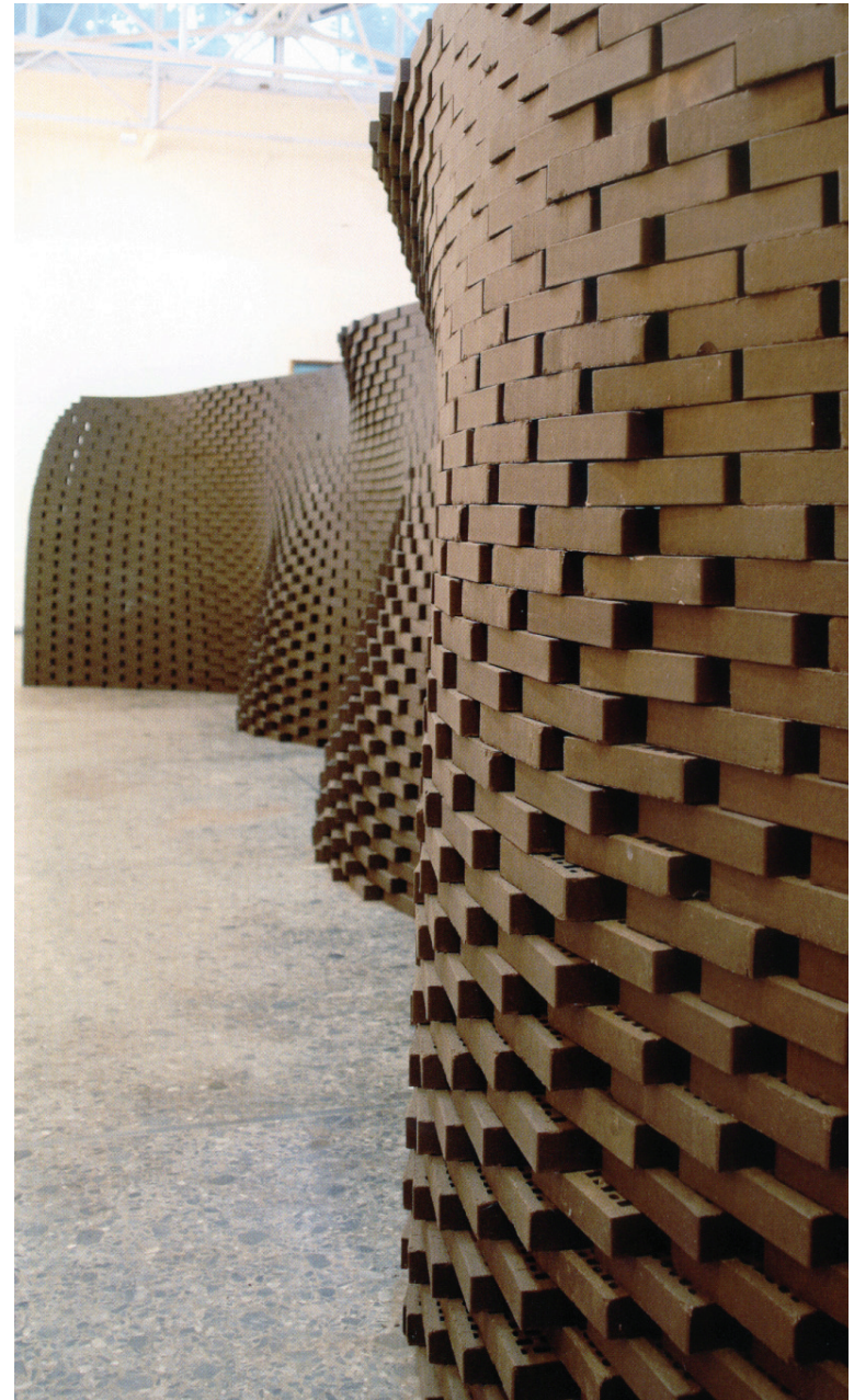
Abbildung 41: Die ETH Zürich kann mittels ihres Industrieroboters Ziegelwände voll automatisiert aufbauen lassen.
