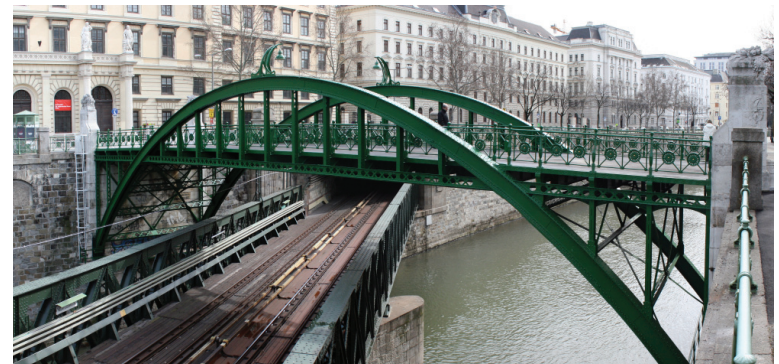
Abbildung 67: Der denkmalgeschützte Zollamtsteg mit darunterliegender U-Bahntrasse.
