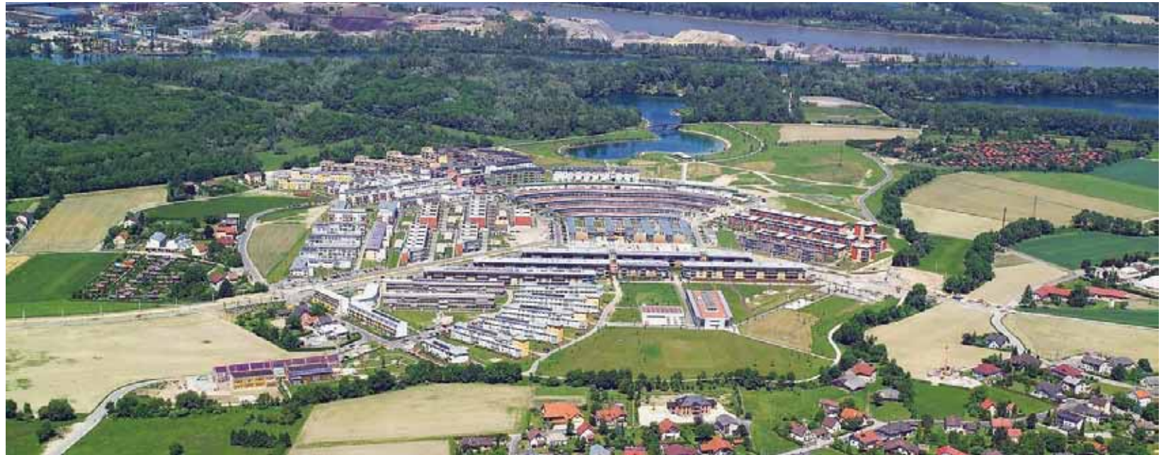
Die SolarCity Linz Pichling von oben Quelle: http://www.linz.at/images/03112005adruk.jpg am 6.3.2012
