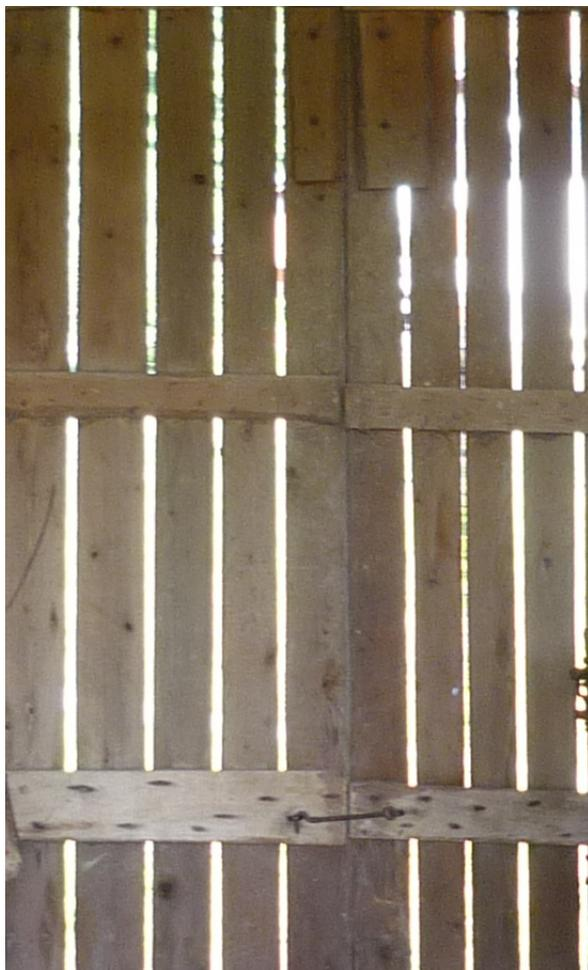
Bild 121. Lichteinfall durch die Fugen der bestehenden Holzstöre
