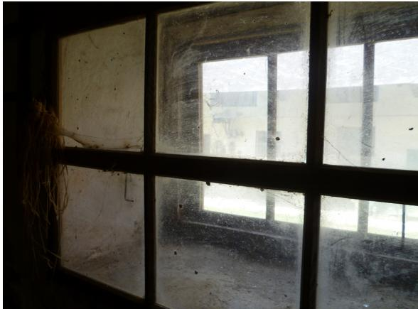
Bild 85. Doppelfenster aus Holz
