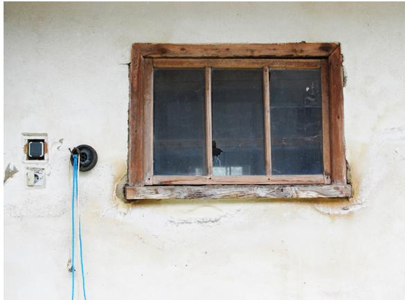
Bild 49. Doppelfenster aus Holz
