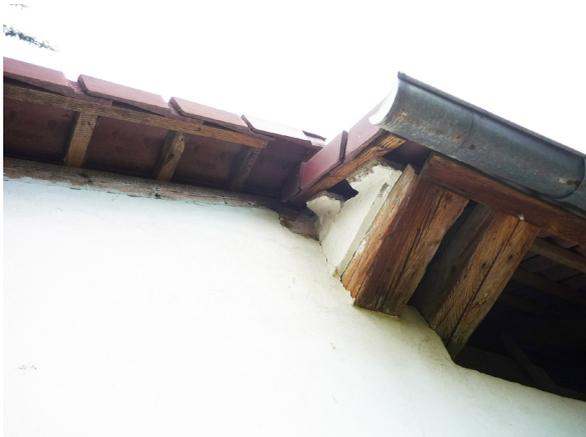
Bild 43. Übergang zwischen Satteldach und Pultdach
