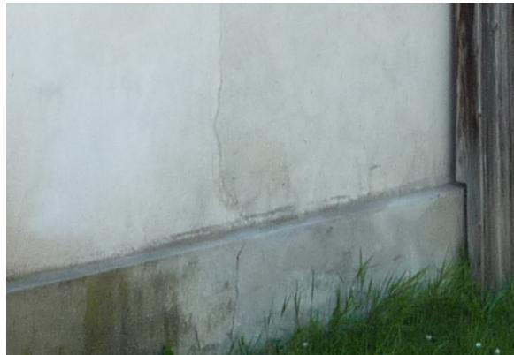
Bild 113. Bestehende unebene Putzfläche mit hervortretendem Sockel
