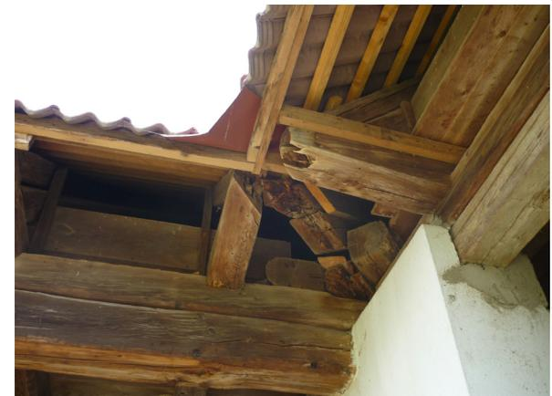
Bild 42. Eckverbindung der beiden Dachstühle
