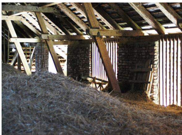
Bild 95. Außenmauern des aufgestockten Dachstuhles
