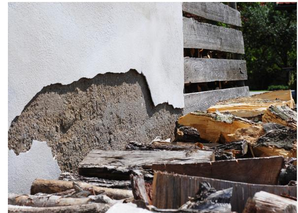
Bild 60. Schäden am Putz
