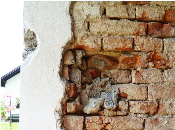
Bild 80. Vollziegelmauerwerk
