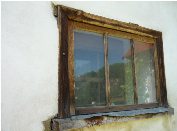
Bild 44. Doppelfenster aus Holz
