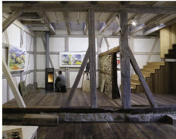
Bild 15. Ergänzte Holzkonstruktion im Atelier
