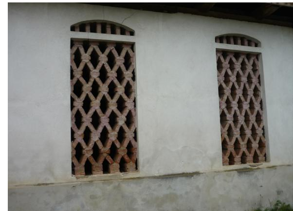
Bild 37. Ziegelornamente zur Belichtung und Belüftung
