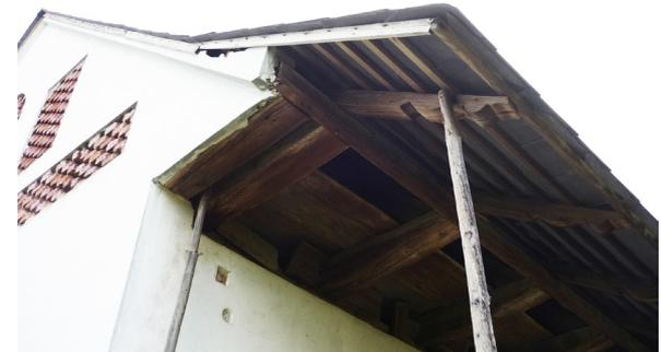
Bild 59. Traufe mit auskragendem Dach
