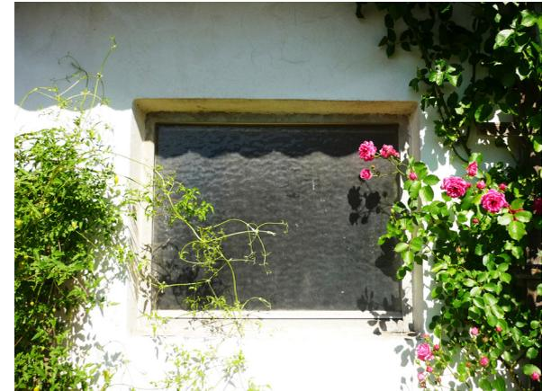
Bild 47. Stahlfenster zur Belichtung der Sauküche
