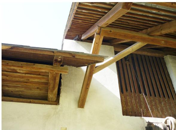
Bild 56. Übergang zwischen den unterschiedlich hohen Gebäudeteilen
