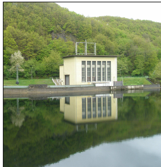
Abbildung 2. Ansicht altes Krafthaus [eigene Aufnahme 2010]
