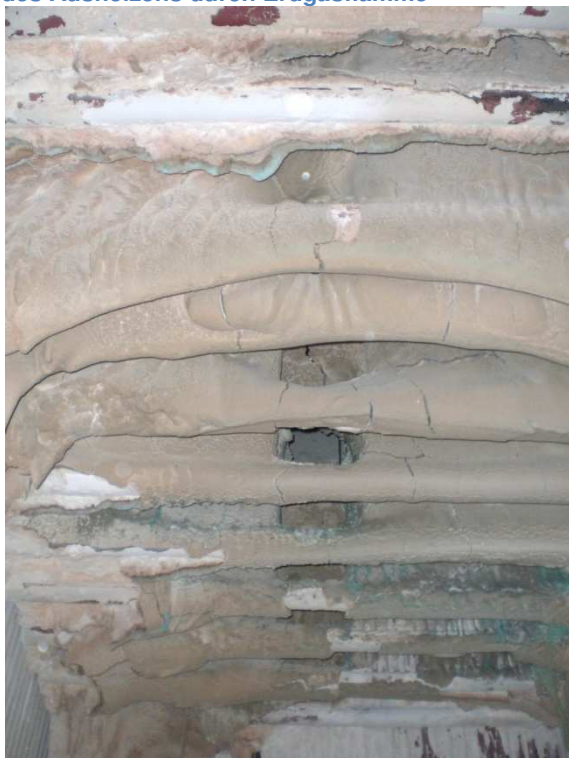
Abbildung B-6-3: Fouling am Überhitzer 3
