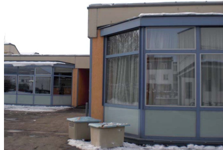
Abbildung 4-20: Polygonale Vorbauten Hauptschule Mitterdorf i. M.
