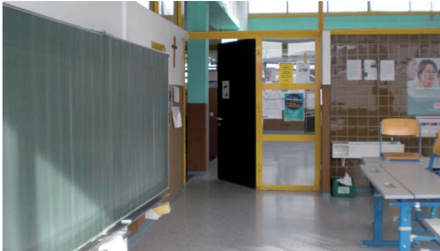
Abbildung 4-24: Fußboden Hauptschule Mitterdorf i. M.
