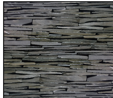
Schichtmauerwerk aus balinesischem Schiefer
