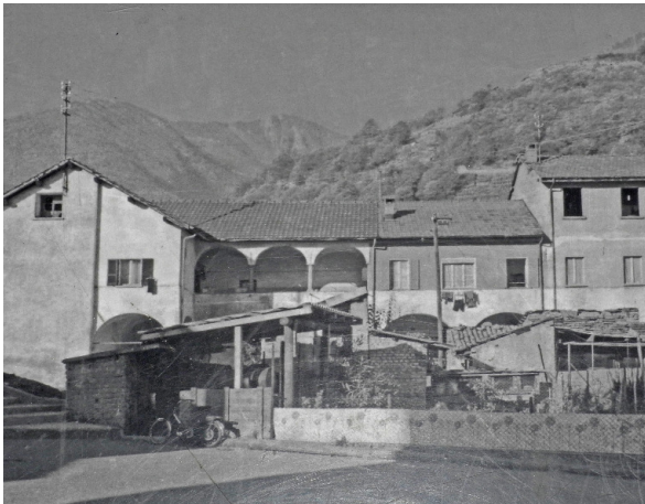
67 „Scuola elementare, Bestandssituation 1987“
