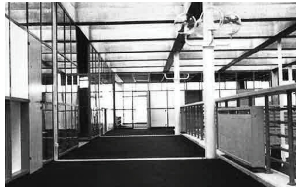
23 „Erschließungsgalerie vor dem Umbau“
