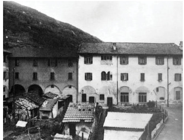
68 „Scuola elementare, Bestandssituation 1987“
