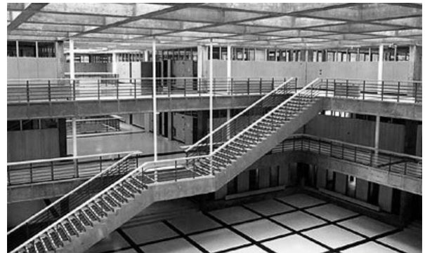
22 „Bundesschulzentrum Wörgl nach dem Umbau“
