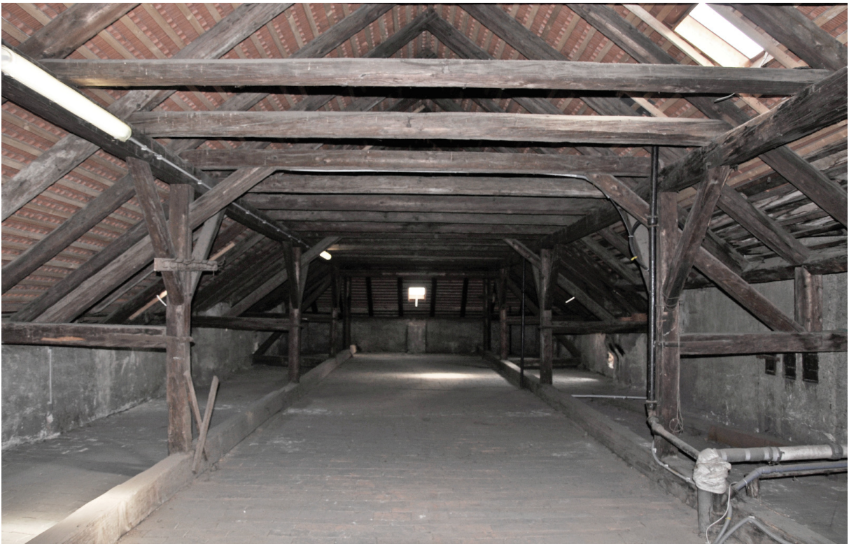
145 „Leerstehender nicht ausgebauter Dachboden“
