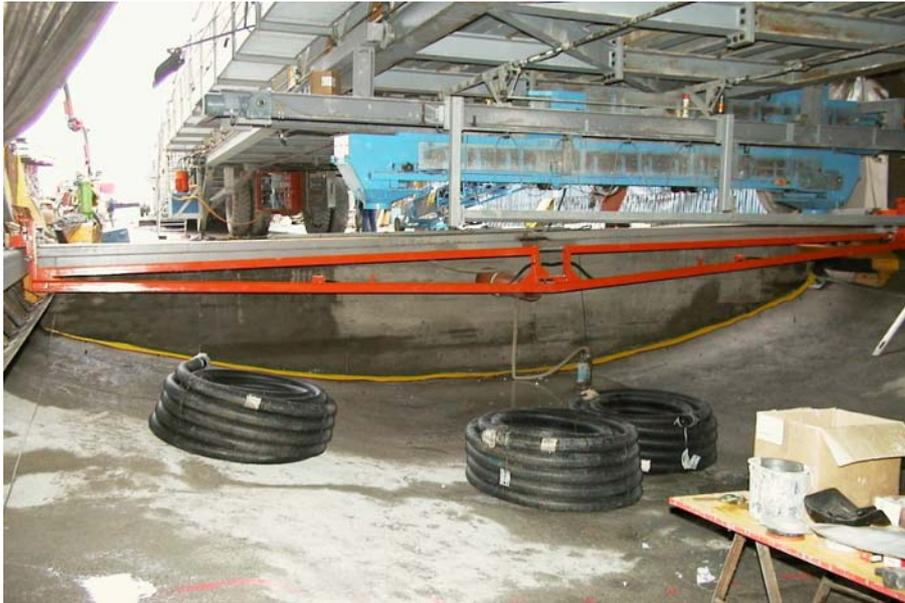
Abbildung 22: Betonverteiler<sup>24</sup>
