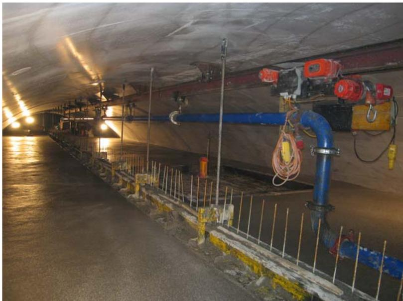
Abbildung 9: Zwischendecke - Pfändertunnel II. Röhre<sup>10</sup>
