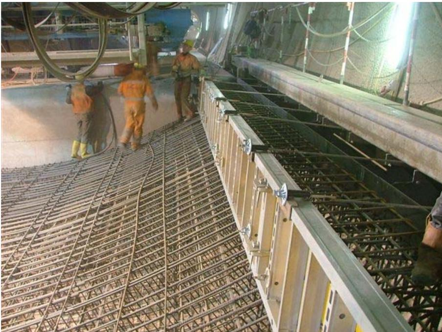
Abbildung 21: Schalung der Widerlager<sup>22</sup>
