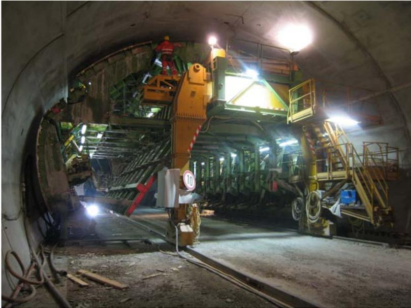
Abbildung 8: Pannenbuchschalwagen - Pfändertunnel II. Röhre<sup>9</sup>
