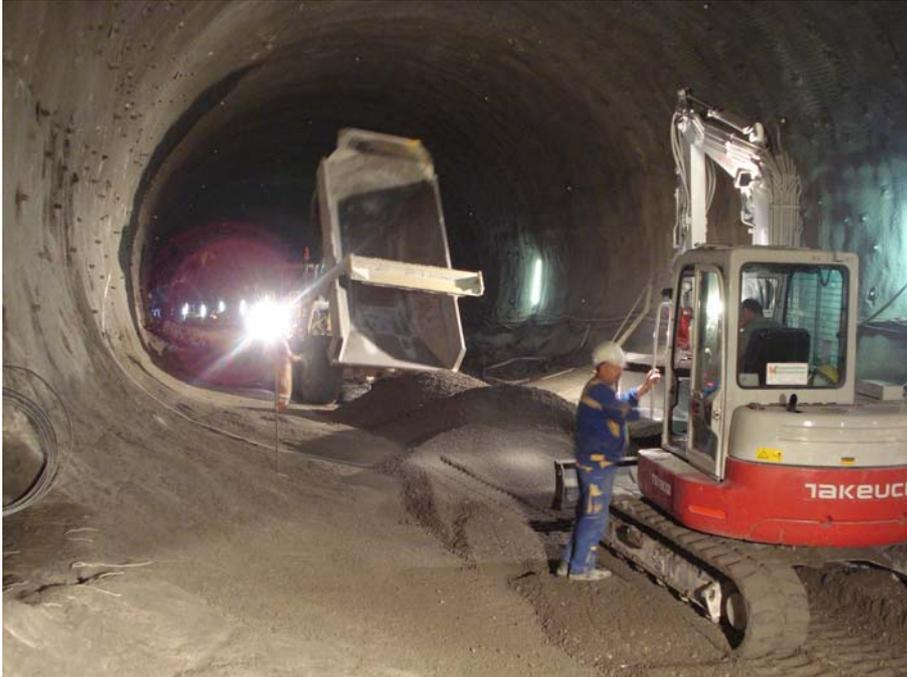
Abbildung 24: Einbau des Walzbetons<sup>31</sup>
