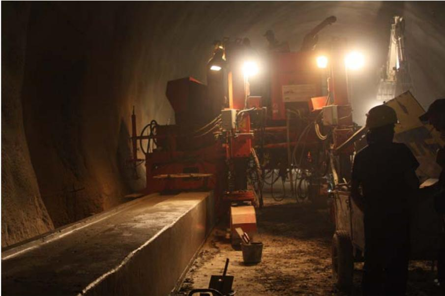
Abbildung 26: Widerlager gleiten<sup>33</sup>
