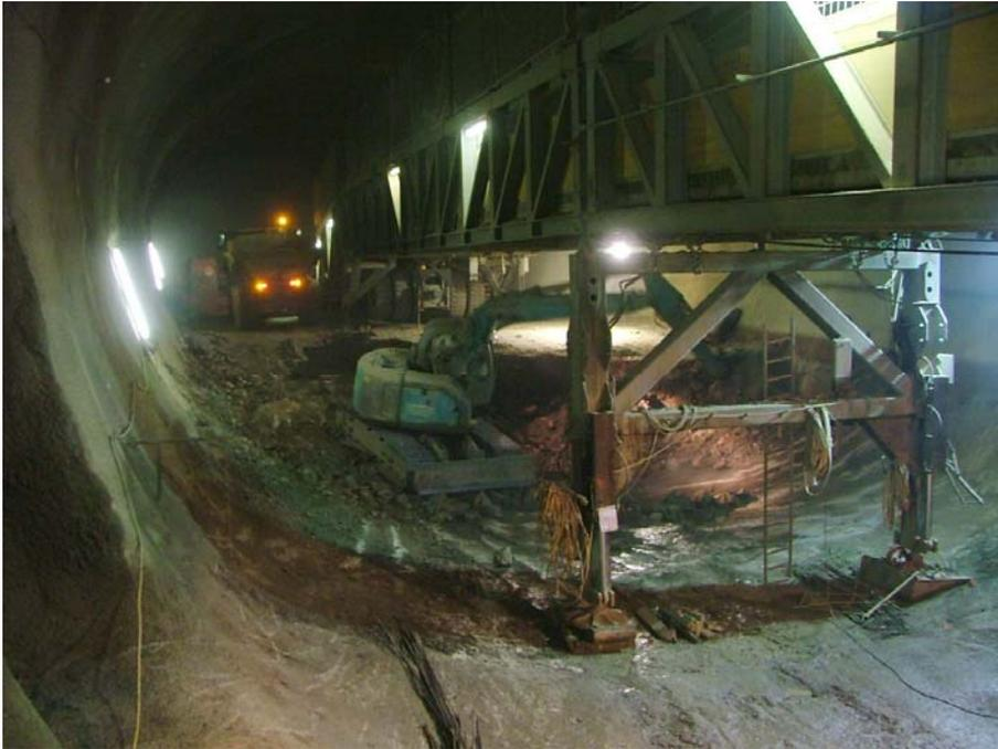
Abbildung 23: Aushub der Fahrbahnsohle<sup>25</sup>
