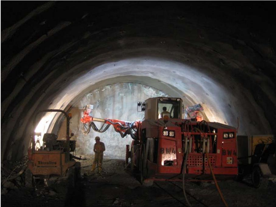
Abbildung 7: Bohren der Sprenglöcher
