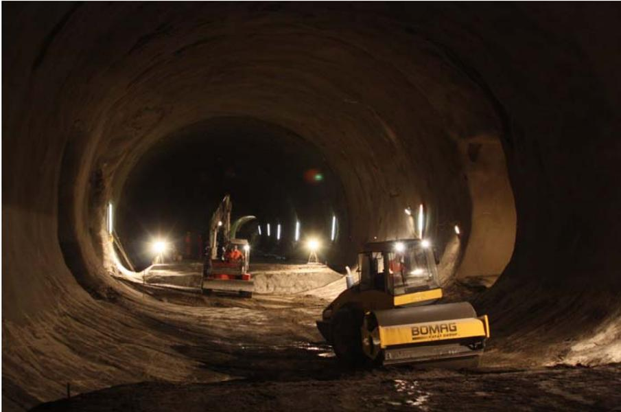
Abbildung 25: Verdichten mit einer Vibrationswalze<sup>32</sup>
