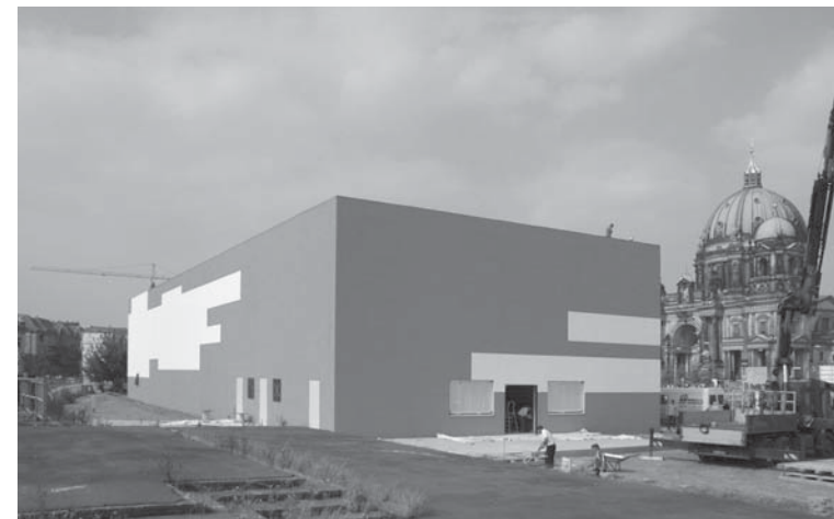
TEMPORÄRE KUNSTHALLE AUSSTELLUNGS- HALLE 2008 HOLZ & FASERZEMENT PLATTEN ABB. 012
