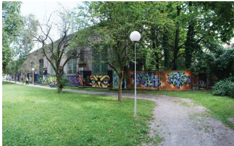
SÜDEN NORDFASSADE POSTGARAGE JULI 2013 ABB. 071
