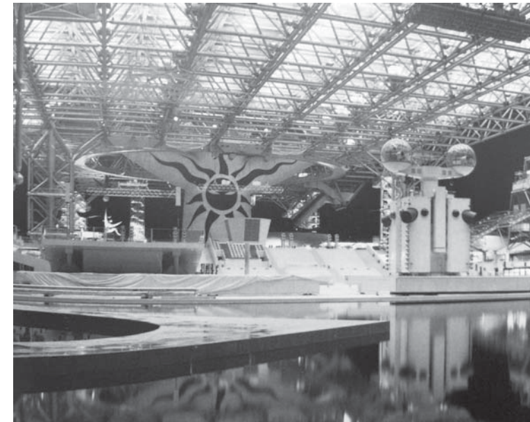
BIG ROOF EXPO OSAKA 1970 RÄUMLICHES FACHWERK ABB. 004
