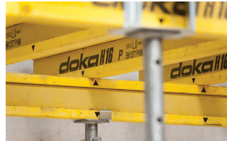
DECKEN- SCHALUNG- TRÄGER
