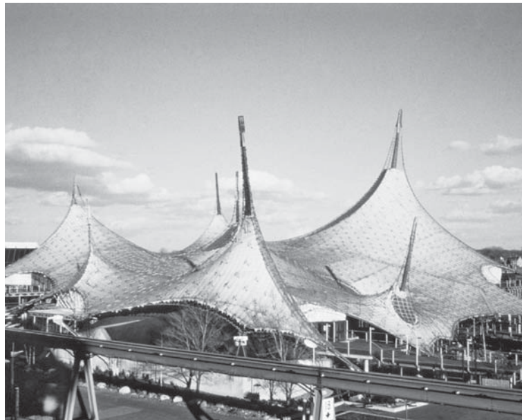
DEUTSCHER PAVILLON EXPO MONTREAL 1967 MEMBRAN- KONSTRUKTION AUS STAHLSEITNETZ ABB. 002
