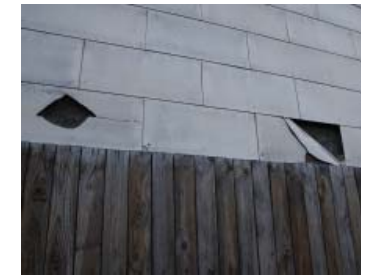
Fig. 45: White asbestos shingles
