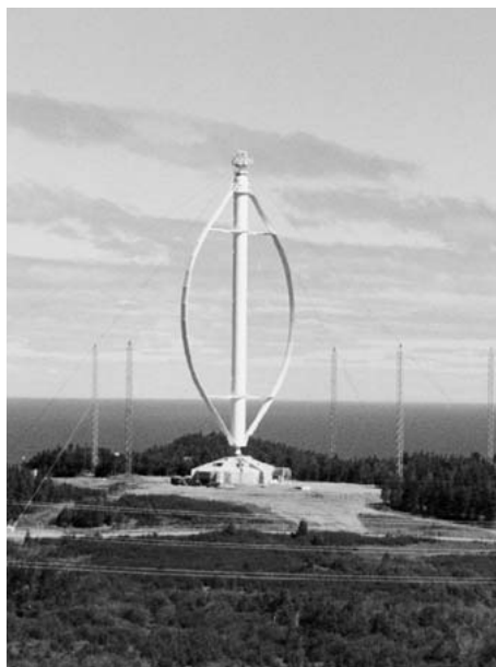
Fig. 2 4 MW Darrieus-Rotor [6]
