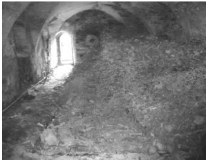
Unterkapelle nach dem Entfernen der Lüftungsschächte, von Gerümpel und des Holzverschlages
