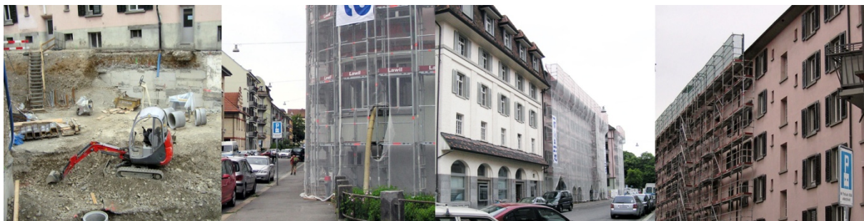
Abbildung 30, Eindrücke aus Stadtkreis 4- umfassende Sanierungen
