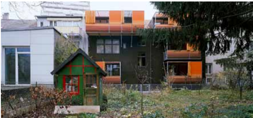
Abb.: Goethestrasse 40 Architekten: Innoad, 2002 © Paul Ott
