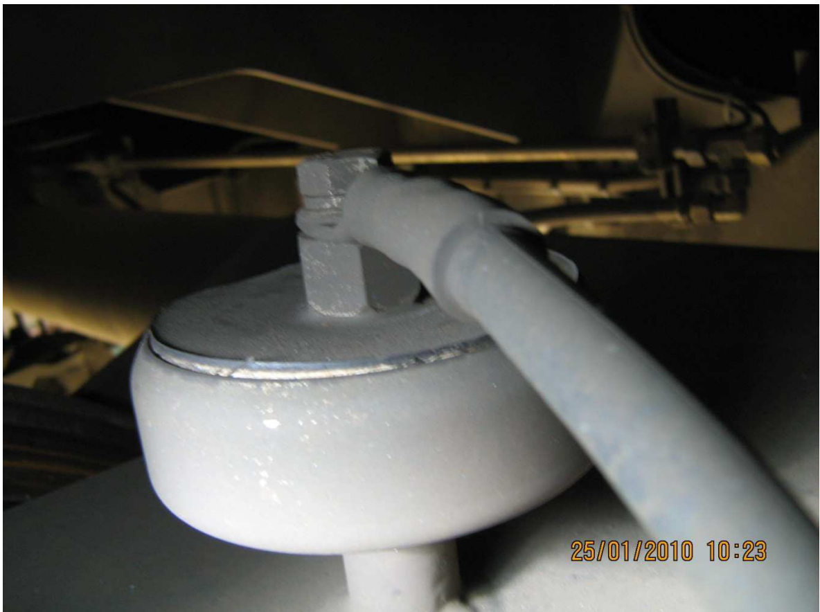
Abb. 74: Schädigung durch Wasser in der Vergussmasse einer Lokomotive
