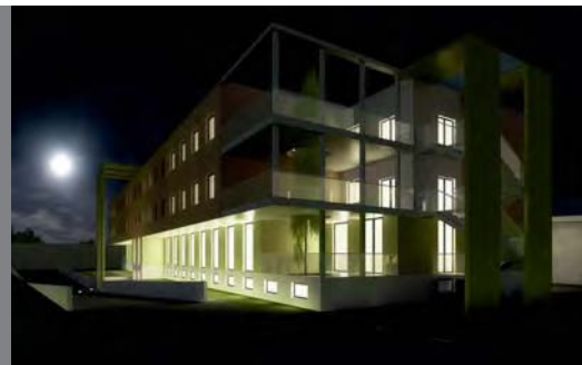
Nachtszene der Nordwest- und Nordostfassade
