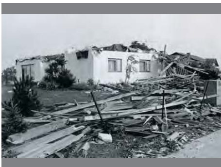
Abb.71 Unwetterschaden eines Hauses in Straß
