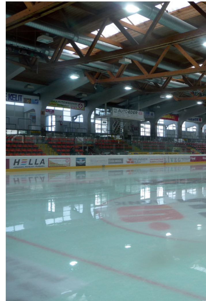
Abb. 36: Innenraum (Keine Sorgen Eisarena)
