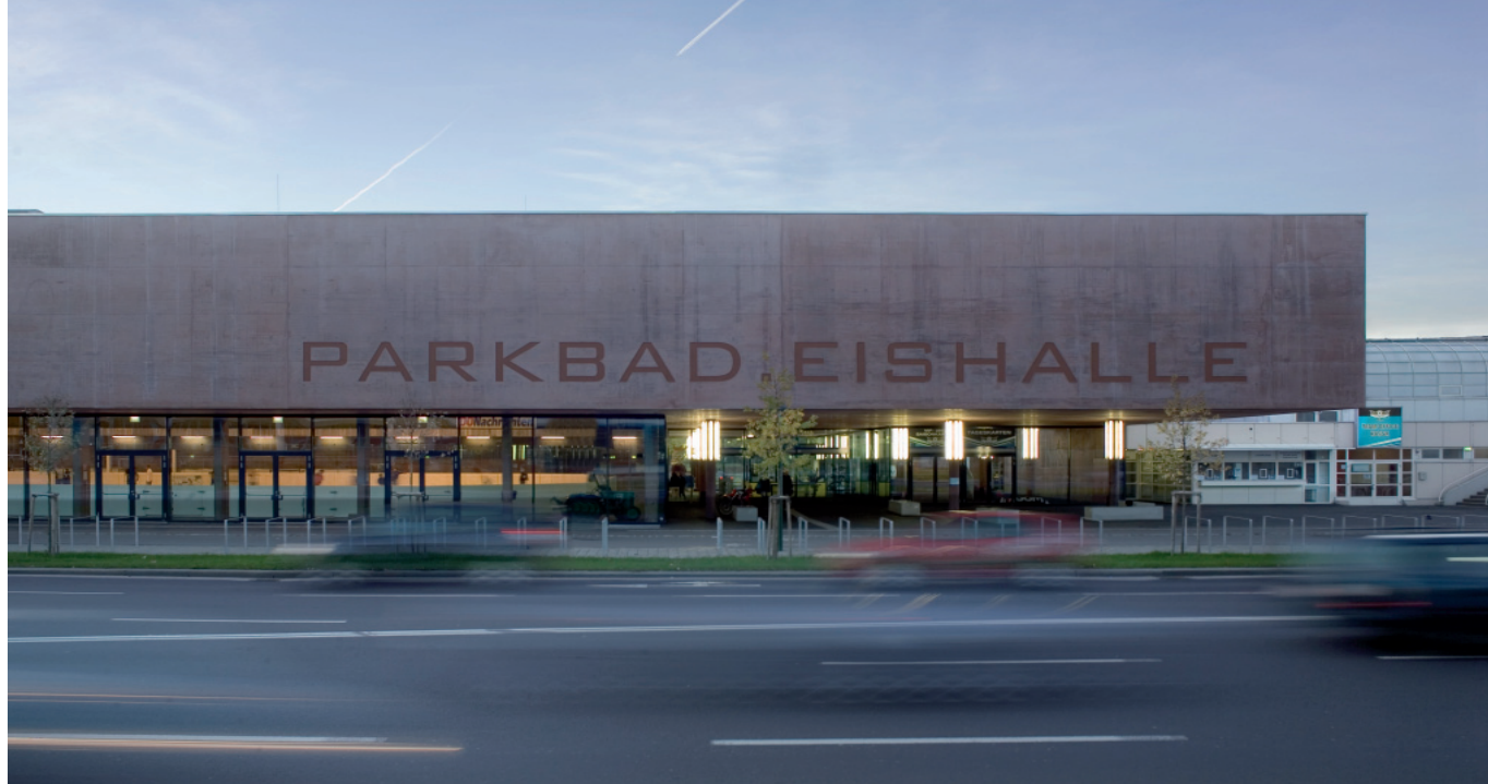
Abb. 39: Neue Eishalle Linz (Parkbad)
