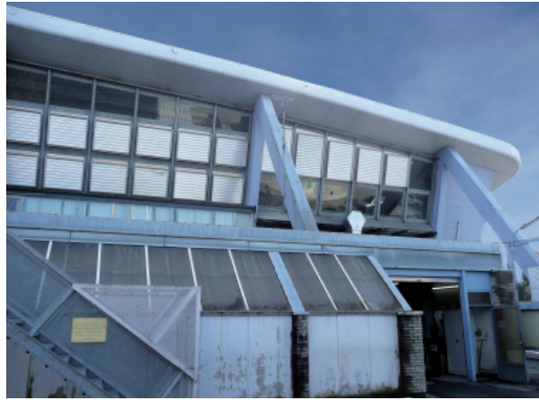
Abb. 15: Liebenauer Eishalle - Nordseite
