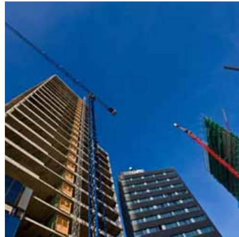
Hochhausbaustellen am Fòrum
