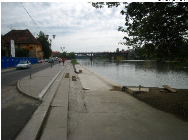
Uferpromenade, Blickrichtung von Steg Richtung Osten
