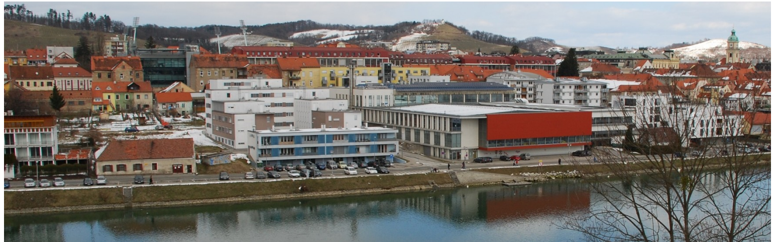
Foto: Blick von Süden auf die Silhouette entlang der Drau im Bereich der Wohnbebauung und des städtischen Hallenbades (rot)
