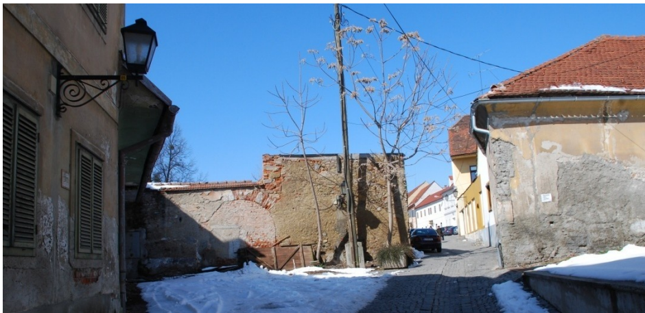
die Kasernengasse in Blickrichtung Kasernenplatz
