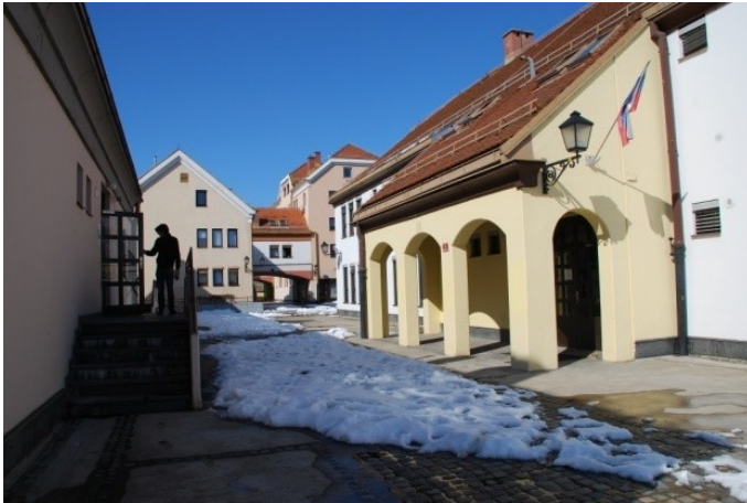
links: der Innenhof und das Schulgebäude
