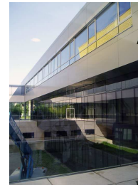
Blick aus Bauteil E in den Innenhof zwischen den Bauteilen E-F-G: rechts NO-Fassade Bauteil F, links Verbindungsgang zu Bauteil G
