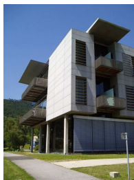
Links SW-Fassade und rechts Teil SO-Fassade von Bauteil D
