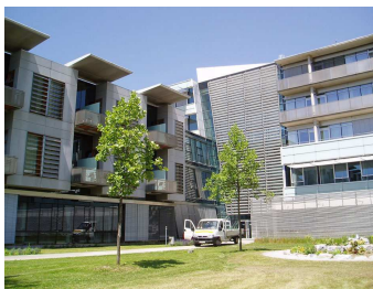
SO-Fassade Bauteil D, Anschluss an SW-Fassade Bauteil AB (Mitte) und Fortsetzung durch SW-Fassade Bauteil C
