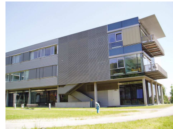
Links Teil NW-Fassade und rechts SW-Fassade von Bauteil D
