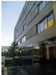
Blick aus Bauteil E in den Innenhof zwischen den Bauteilen C-E-F: rechts NO-Fassade Bauteil C, links Verbindungsgang zu Bauteil F
