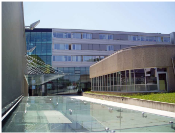
NO-Fassade von Bauteil AB mit verglastem Eingangsbereich links, rechts Hallenbad des UKH
