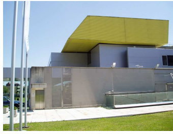
NW-Fassade Bauteil E im Anschluss an die NO-Fassade von Bauteil G (links)
