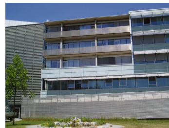
SW-Fassaden der Bauteile AB (links) und C (Mitte und rechts)
