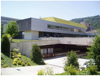
Oben SO- (links) und NO-Fassade (rechts) von Bauteil G, rechts darunter Wirtschaftszufahrt (Bauteil H)
