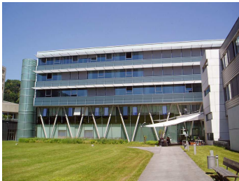
SW-Fassade Bauteil AB, links schließt UKH an, rechts Bauteil D
