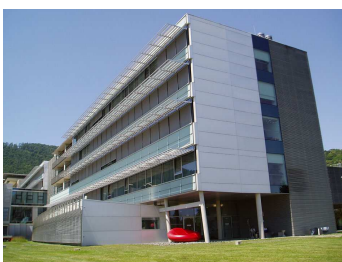
SW- (links) und SO-Fassade (rechts) von Bauteil C
