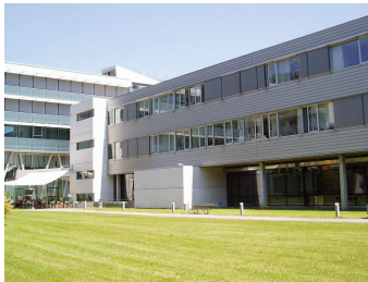
Rechts NW-Fassade Bauteil D, links hinten SW-Fassade Bauteil AB
