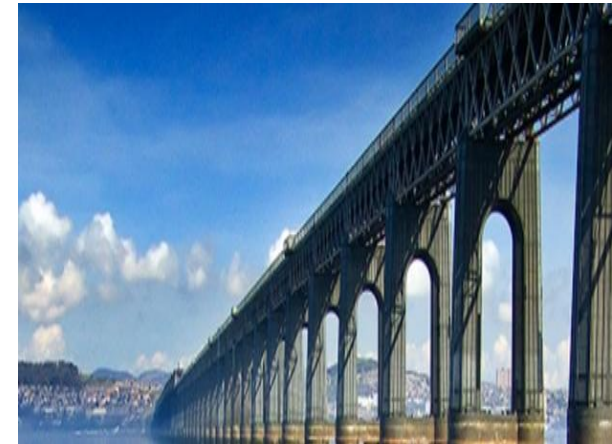
Abb. 58: Eisenbahnbrücke „Firth of Tay“, 1887 erbaut
