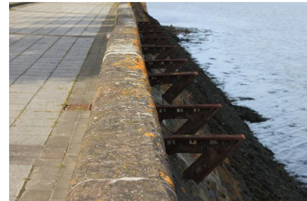
Abb. 101: Derzeitige Situation der Uferkante
