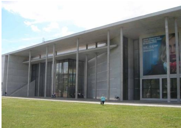
Abb. 25: Pinakothek der Moderne, München Eingangssituation
