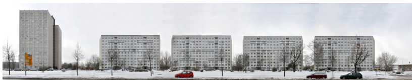
06 Großsiedlung an der Straße des 18. Oktober
