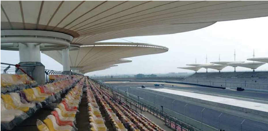
Abb. F.9. Tribünenüberdachung des Shanghai International Circuit
