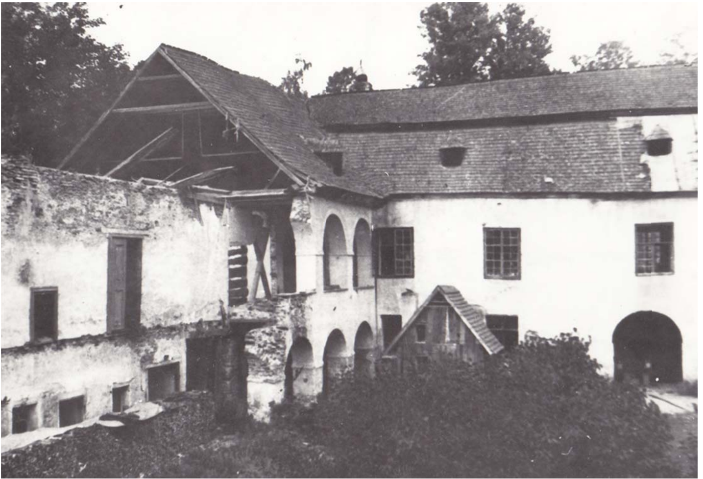
Abb. A.12. teilweise verfallene Arkadengänge 1950
