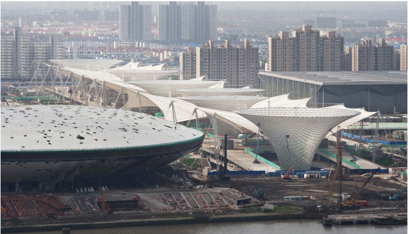
Abb. G.3. Luftbild des Expo-Boulevards
