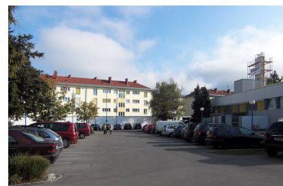
Abb. 32: Hallenbad Bestand, Parkplatzsituation
