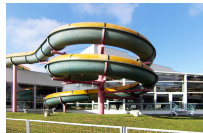
Abb. 31: Hallenbad Bestand, Westansicht
