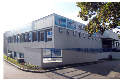
Abb. 29: Hallenbad Bestand, Nordansicht
