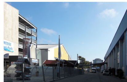
Abb. 55: Standort „Messegelände“, Messehalle 6
