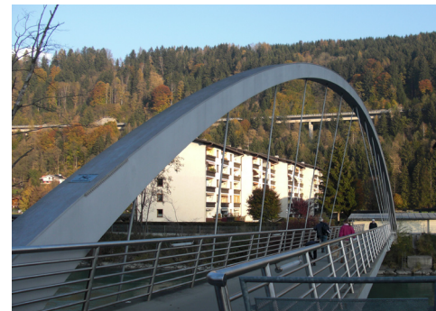
Stegbrücke über die Salzach
