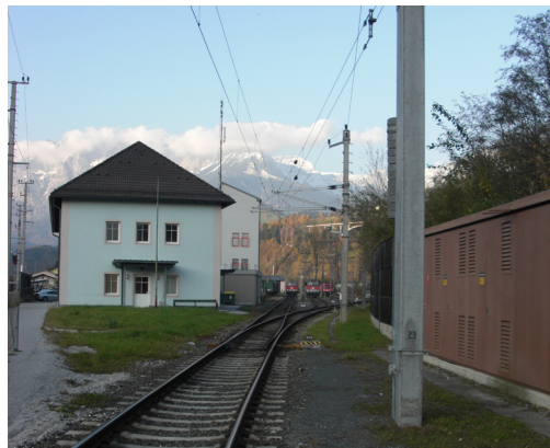
ÖBB Infrastruktur Betrieb AG
