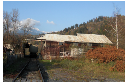
Schuppen auf dem Areal der Remise
