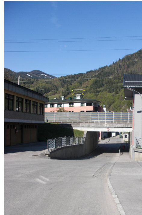
Eisenbahnunterführung in die Heizhausgasse
