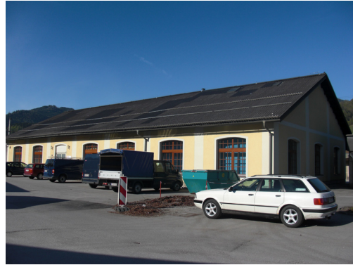
ÖBB Technisches Gebäudeservice Bischofshofen
