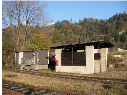
Schuppen auf dem Bauareal
