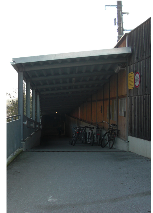
Unterführung Zugang zu den Bahnsteigen 1-7
