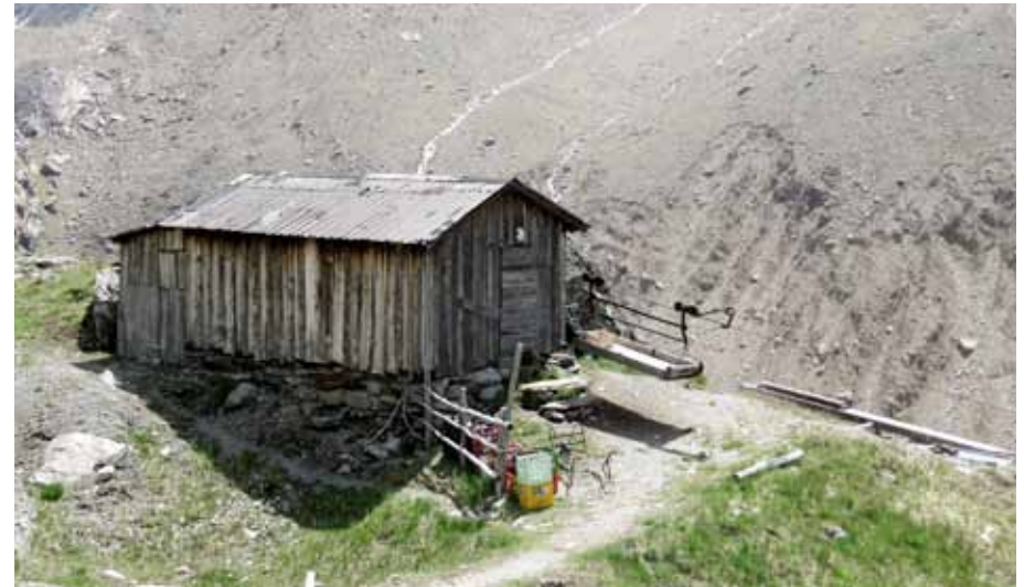
Bergstation der Materialseilbahn
