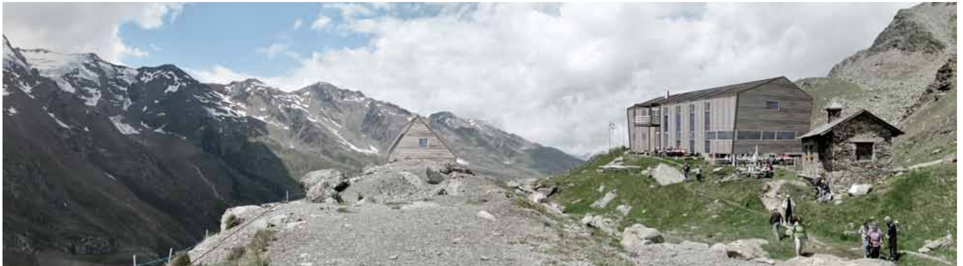
Blick von Osten auf die neue Weißkugelhütte
