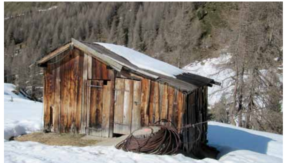
Talstation der Materialseilbahn
