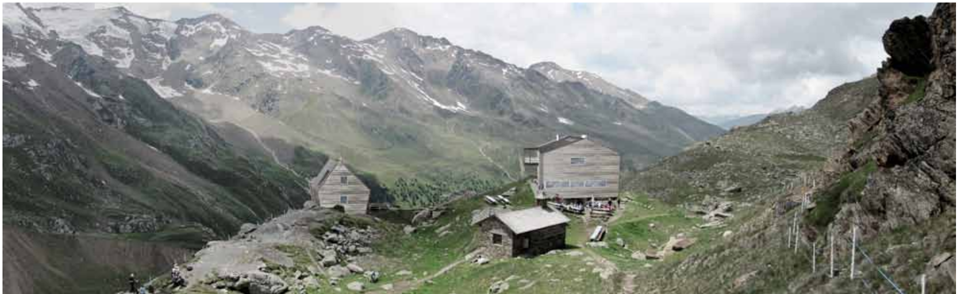
Blick Richtung Westen auf die neue Weißkugelhütte und das Langtauferertal
