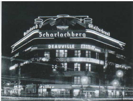
Gebrüder Luckhardt und Alfons Anker, Geschäftsgebäude Berlin Kurfürstendamm 211, Nacht- und Tagansicht
