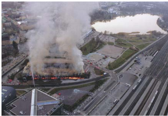
Brand 5. Mai 2006 RAilway Warehouse, aktueller Bauplatz
