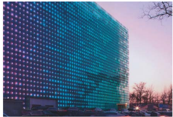
Greenpix Beijing Medienfassade
