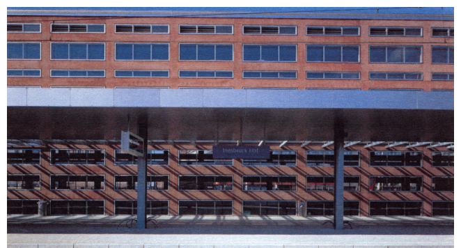
Abb. 033: Frontalansicht Hauptbahnhof Innsbruck
