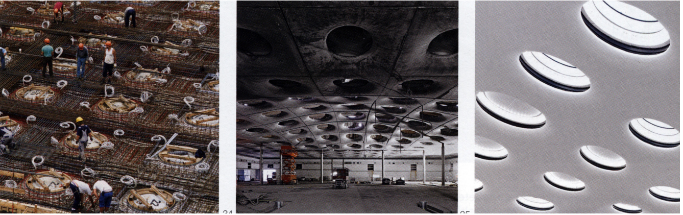
Abb.048: Errichtung der gewölbten Decke
