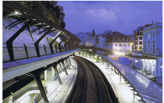
Abb. 007 Stadelhofen Station; Bahnsteige
