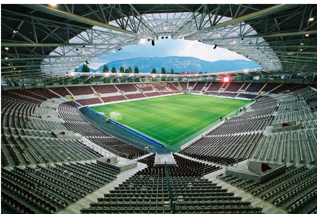
Abb.066: Genfer Stadium; Tribünen - Ansicht
