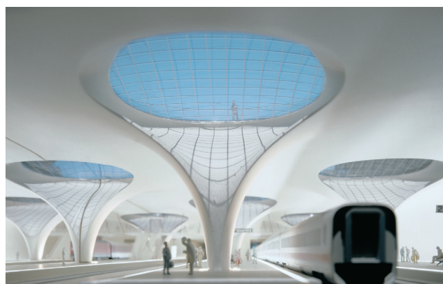
Abb. 011 Tragstruktur Betonschale
