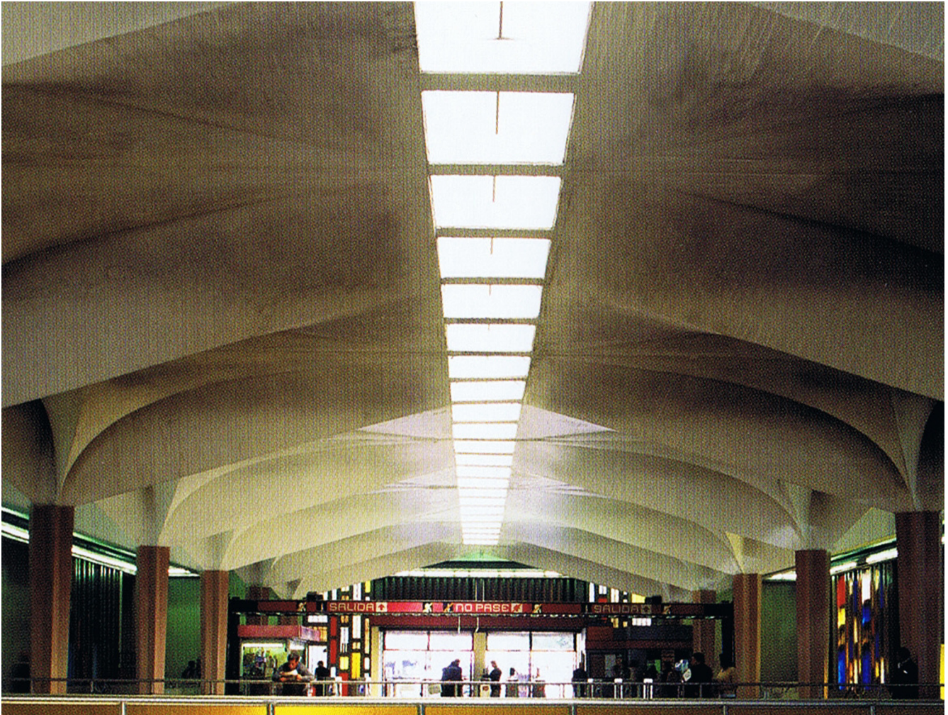
Abb. 020: U-Bahnstation Candelaria; Innenansicht
