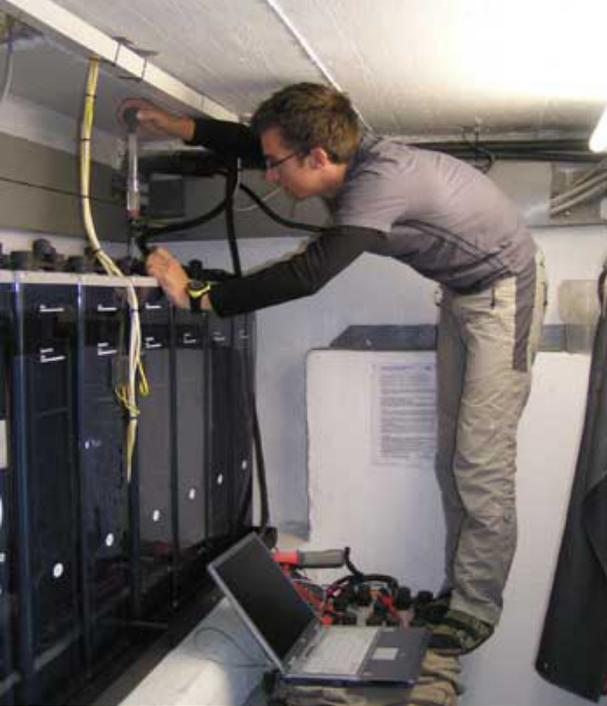
Abb.6: Test der Batterieanlage im Brandenburger Haus im Ötztal um Säureschichtung zu überprüfen / Foto: Baur 2007
