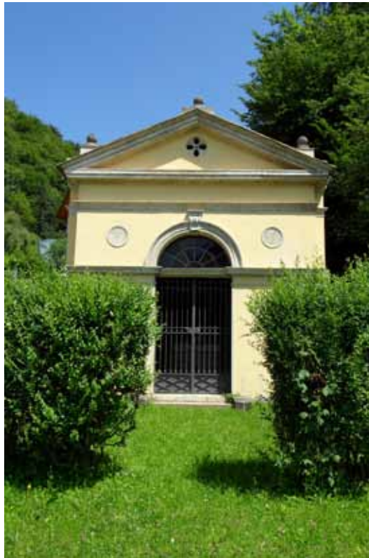
Abb. 62: Ansicht der Badlwand- Kapelle, in Nähe des Nordportals; 06/2011
