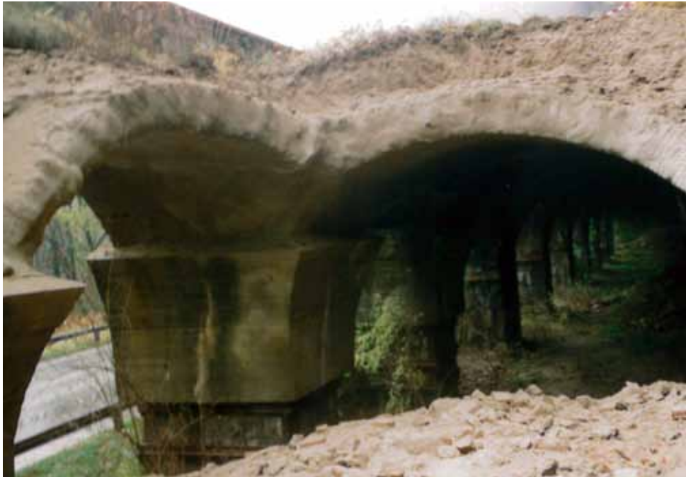
Abb. 151: Gesicherte Flächen bei Pfeiler 34, mit Tunnelröhre; 11/2000
