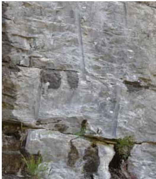
Abb. 187: Bohrlöcher für die Felssprengungen
