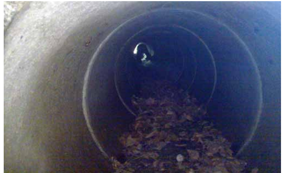
Abb. 136: Kanalrohr unterhalb der Bruckerstraße des Galerieabflusses zwischen Pfeiler 8 und 9, Blick Richtung Mür, 07/2010
