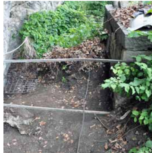
Abb. 190: Freigelegter Wasserabfluss zwischen Pfeiler 8 und 9
