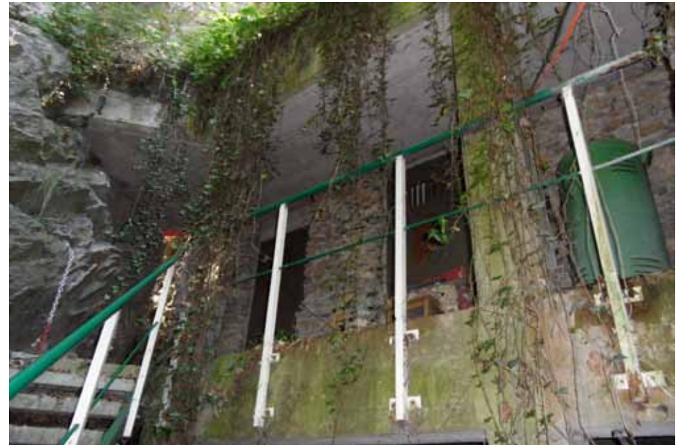
Abb. 56: Bunkeranlage im nördlichen Bereich der Galerie
