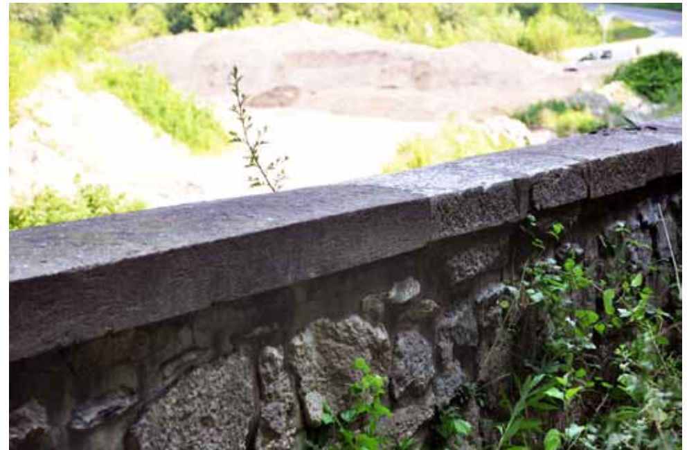
Abb. 14.3: Mauerabdeckplatten, ursprünglich aus Naturkalkstein, teilweise jedoch wie hier mit Beton ersetzt bzw. ergänzt; 07/2010
