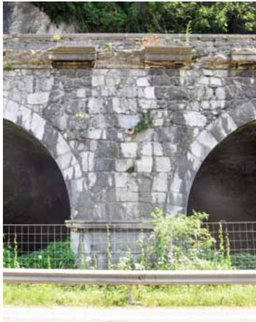
Abb. 112: Pfeiler 26, gut zu erkennen ist die massivere Ausführung; 07/2010
