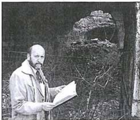
Landeskonservator F. Bouvier: „Das Gewölbe kontrolliert abtragen“ 102/10202
