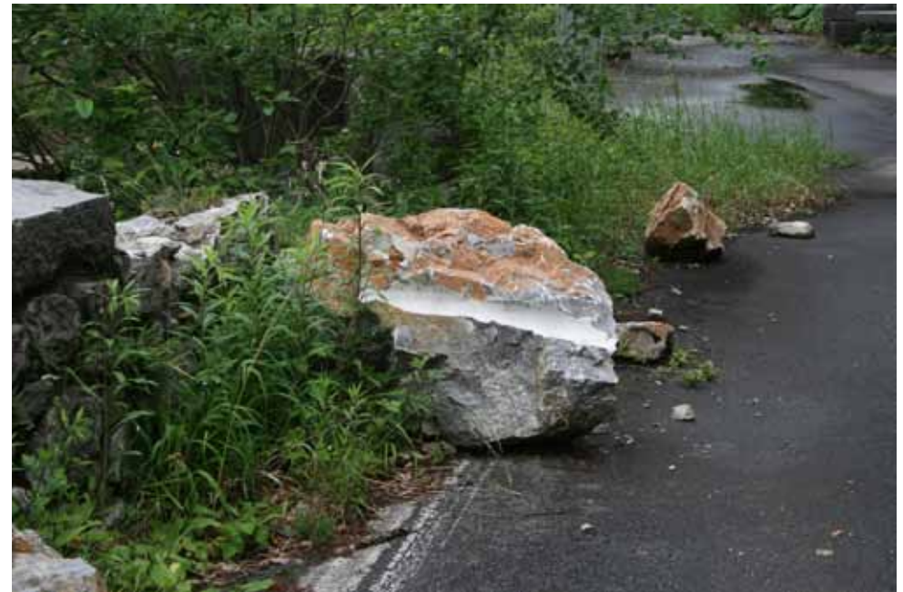
Abb. 149: Felssturz aufgrund von Sprengarbeiten des nahegelegenen Steinbruchs; 06/2011
