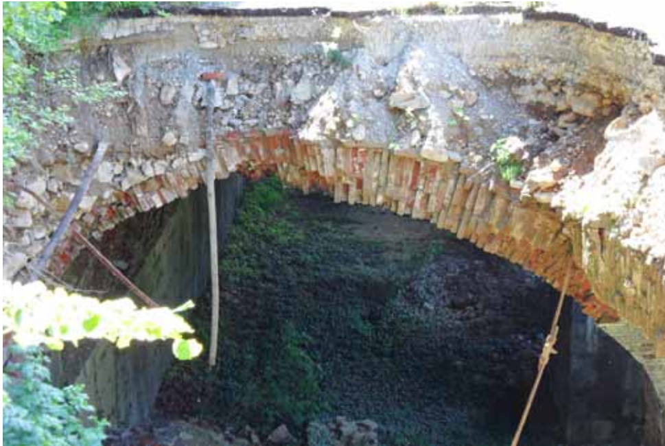
Abb. 148: Gut zu erkennen der nachträglich aufgebrachte Bodenaufbau, oberhalb des Ziegelgewölbes befindet sich die ehem. wasserführende Schicht; 06/2011
