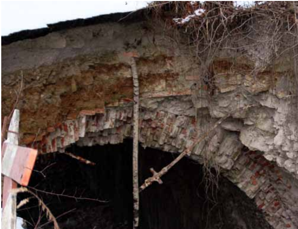
Abb. 116: Gewölbeaufbau mit wasserführender Schicht
