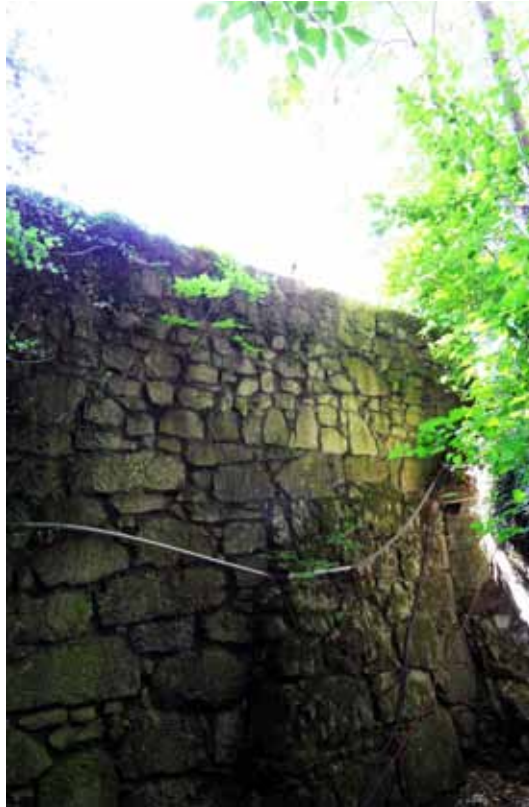
Abb. 55: Stützmauer zwischen Felswand und der nördlichen Zufahrtsstrasse zur Galerie
