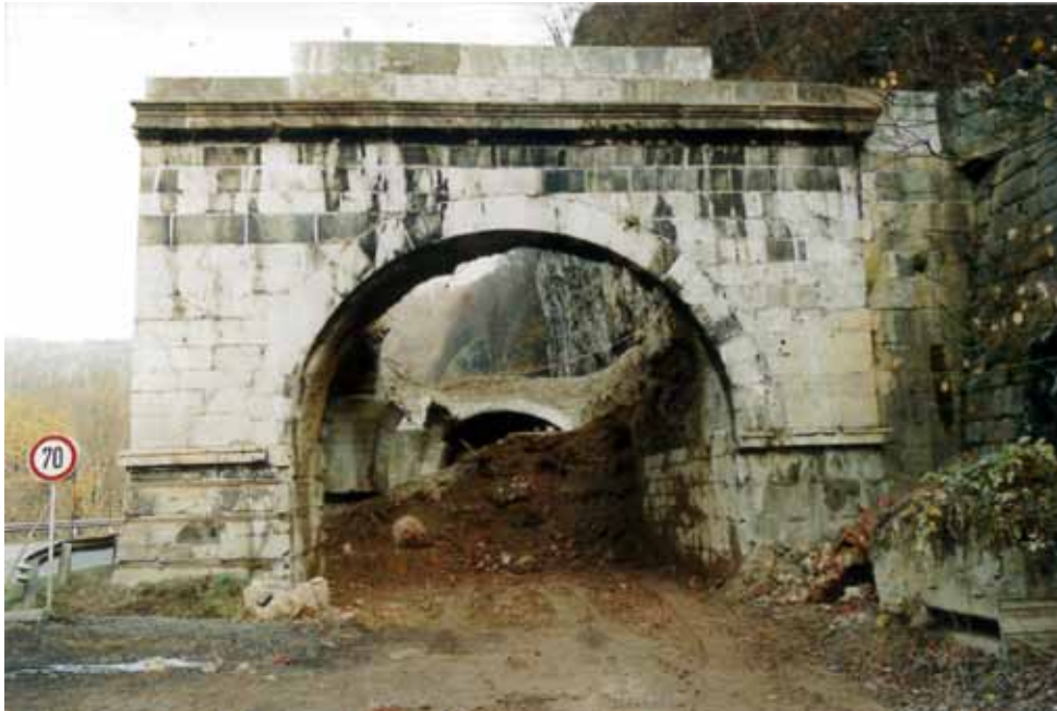
Abb. 154: Südportal nach Abbrucharbeiten im Jahr 2000 mit Abbruchmaterial, 11/2000
