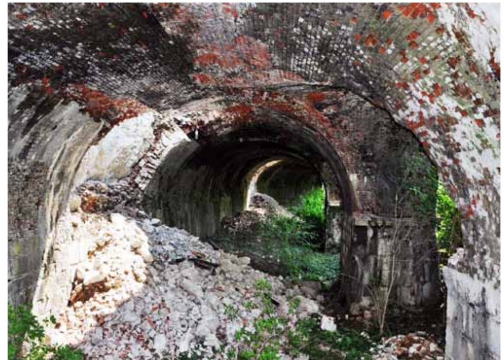
Abb. 186: Unterhalb der Galerie, Blickrichtung Norden; 07/2010
