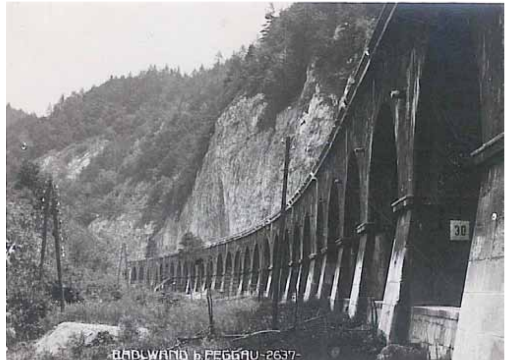
Abb. 91: Entlang der Badlwandgalerie, vor 1939
