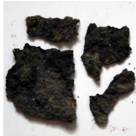
Abb. 146: Versinterung im Bereich der Ziegel bzw. Steinteile, mehrere mm stark
