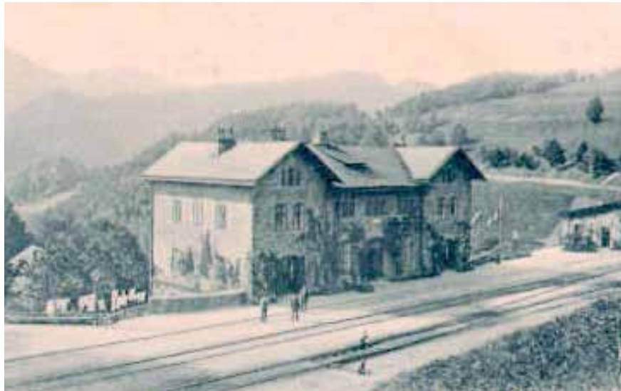
Abb. 72: Gebäude des Bahnhofs Klamm- Schottwien, 1900
