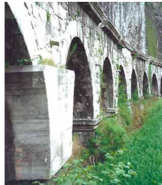
Abb. 95: Betonmanschette an Pfeiler 2, 02.05.2000
