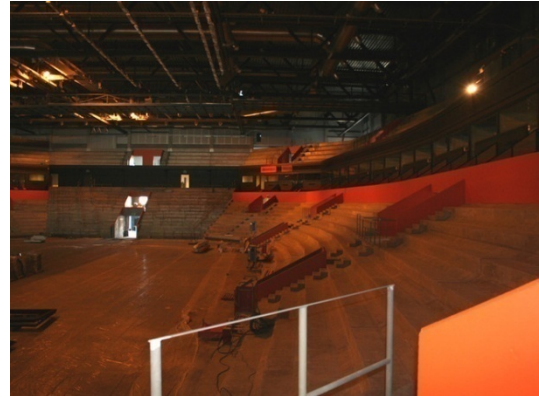
Fig. 35: Die Zugänge zu den Tribünen sind in regelmäßigen Abständen angeordnet, wobei die Tribünen von oben und unten erschlossen werden (Quelle: www.modohockey.se )
