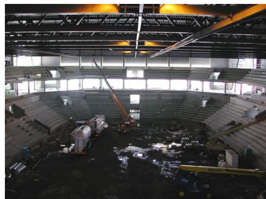
Fig. 54: Das Dach ist fertiggestellt, und die Montage der Eisfläche wird begonnen (Quelle: www.modohockey.se )
