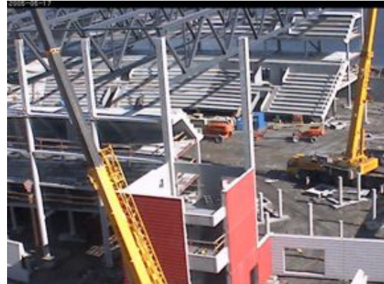
Fig. 52: Die Tribünen sind fertiggestellt, und die Tragkonstruktion des Dachs wird eingebaut (Quelle: www.modohockey.se )
