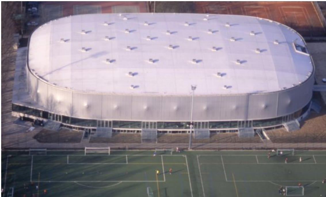
Fig. 57: Luftaufnahme der St. Jakob Arena. Gut erkennbar ist die Fassade des Bauwerks, die aus alubedampftem Gitterstoff besteht, der über Rahmen gespannt wurde. Ebenso sind Teile des umgebenden Sportparks zu sehen. (Quelle: www.zpa.ch , Homepage der Architekten)
