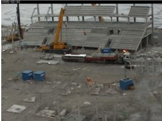
Fig. 51: Bau der ersten Tribüne und der Tragstützen (Quelle: www.modohockey.se )
