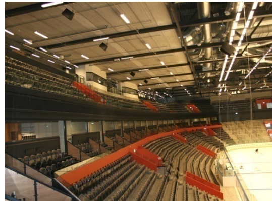
Fig. 37: Die fertig ausgebauten Tribünen mit den installierten Sitzplätzen (Quelle: modohockey.se )
