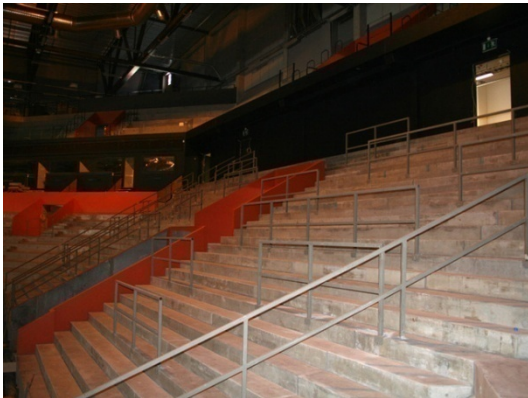
Fig. 36: Die Stehplatztribünen mit den versetzt angeordneten Wellenbrechern (Quelle: www.modohockey.se )
