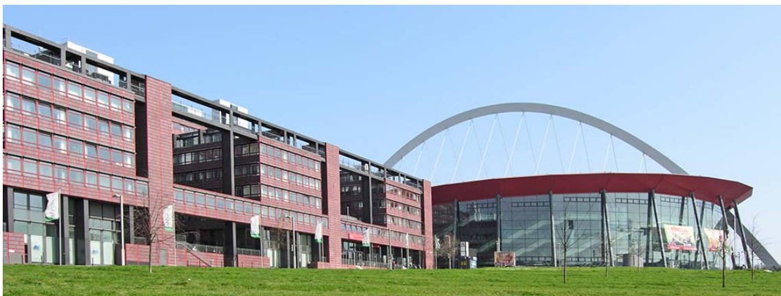
Fig. 63: Die Lanxess-Arena mit der umgebenden Rahmenbebauung. Während die Fassade des Bauwerks mit den Glasflächen vergleichsweise schlicht wirkt, zieht der Bogen die Aufmerksamkeit auf sich und definiert den Charakter der Arena. (Quelle: www.lanxess-arena.de )
