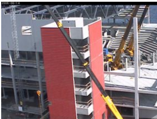
Fig. 53: Die Fassade wird montiert (Quelle: www.modohockey.se )
