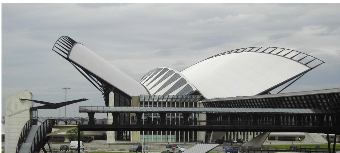
Fig. 84: Ein Teil des Dachs des Flughafens der französischen Stadt Lyon wurde mit Alkorplan gedeckt und zeigt, wie das Material bei verschiedensten Dachformen angewandt werden kann. (Quelle: Homepage von Alkorplan)
