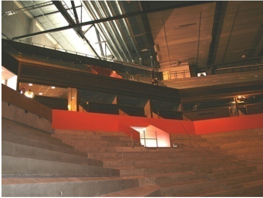
Fig. 34: Die Tribünen des Fjällraven-Centers im Rohbauzustand (Quelle: www.modohockey.se )
