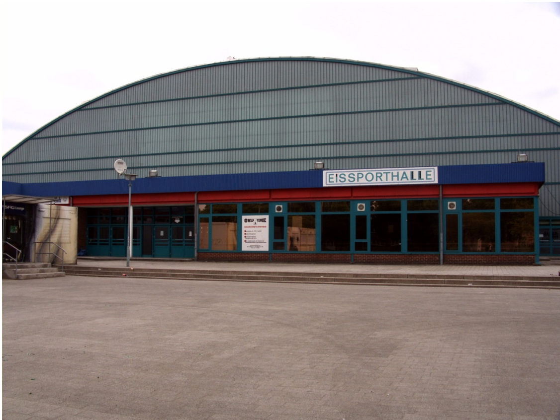
Fig. 5: Der Wellblechpalast in Berlin entstand in mehreren Etappen. Im Jahr 1958 wurde die Kunsteisbahn eröffnet, der erst in den frühen sechziger Jahren die Überdachung folgte. Er ist archetypisch für die Eissportzentren des mittleren zwanzigsten Jahrhunderts und wird bis heute von der Stadt Berlin betrieben.
