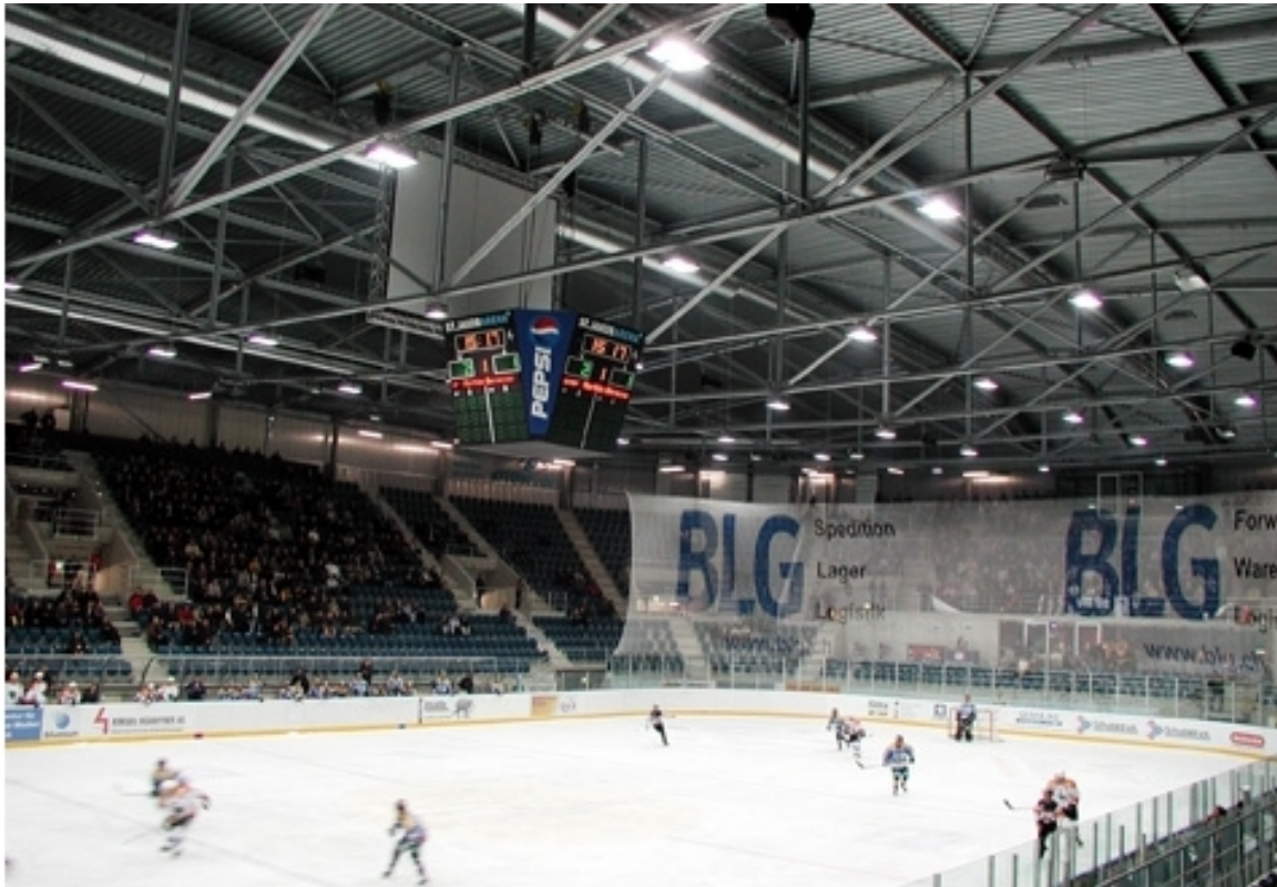
Fig. 24: Die St. Jakob Arena in Basel mit den an der Decke befestigten Deckenstrahlern (Quelle: www.regent.ch )
