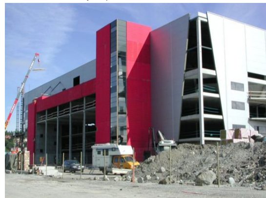
Fig. 56: Außenansicht der Fassade in der Rohbauphase ( www.modohockey.se )
