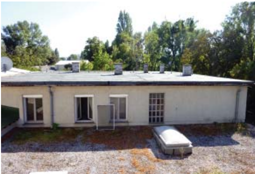
Flachdach über Werkhof/1. OG Direktionsgebäude
