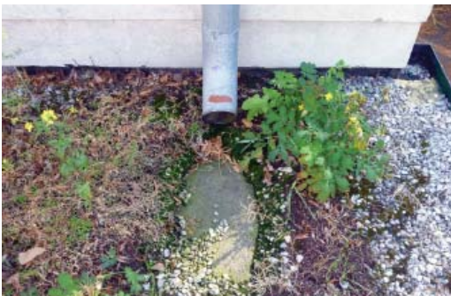
Aufschwimmende Dämmung/Moosbildung
