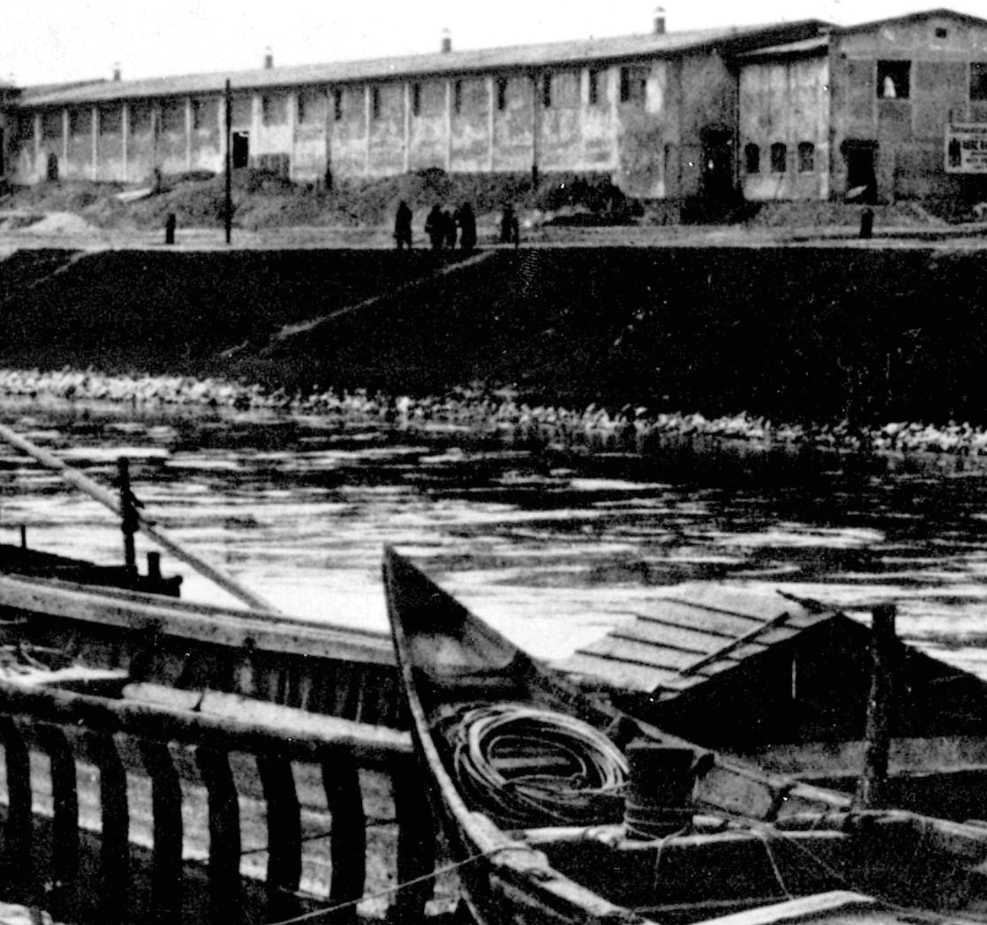
Abb 60: Ansicht während der Bauarbeiten
