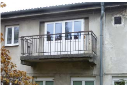
Abplatzungen Balkonplatte
