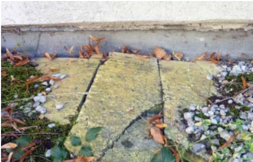
Aufschwimmende Dämmung Flachdach Werkhof
