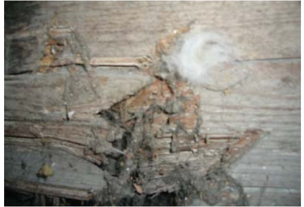
Schadhafter Dachbalken
