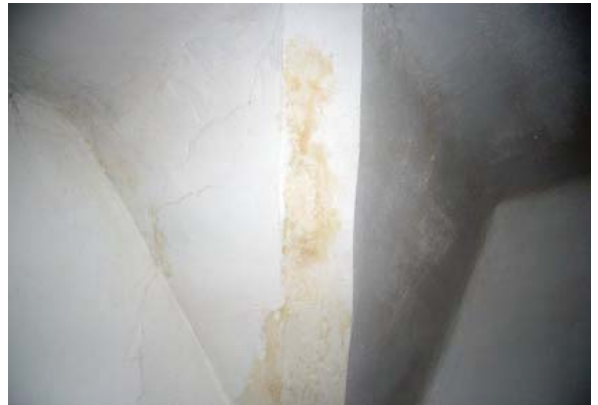
Feuchteschäden 1.OG
