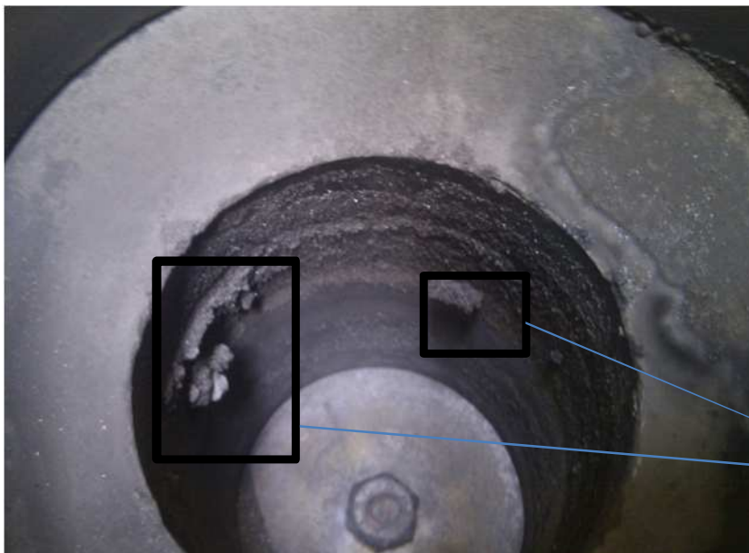
Abbildung 5-48: Anbackungen an der Reaktorwand nach Klärschlamm pelletsversuch V1
