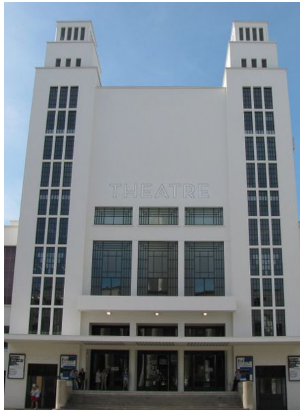
Abb.4. Fassade des TNP nach der Renovierung 2011
