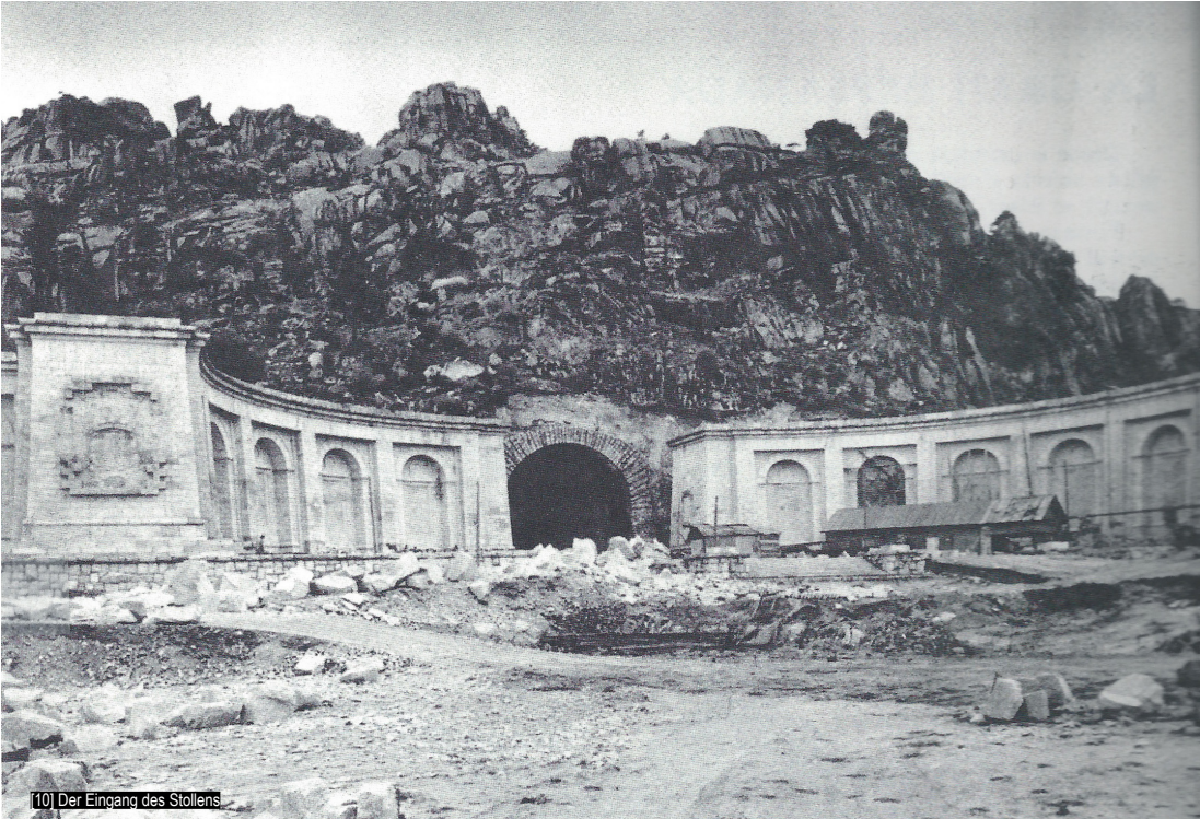
[10] Der Eingang des Stollens
