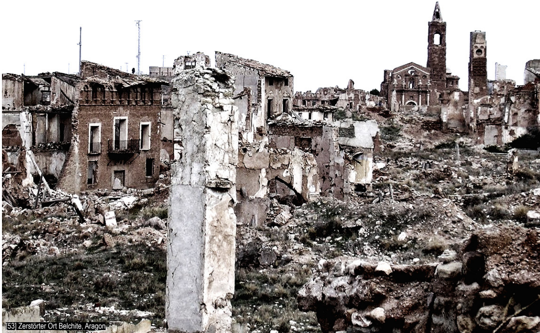
[53] Zerstörter Ort Belchite, Aragon
