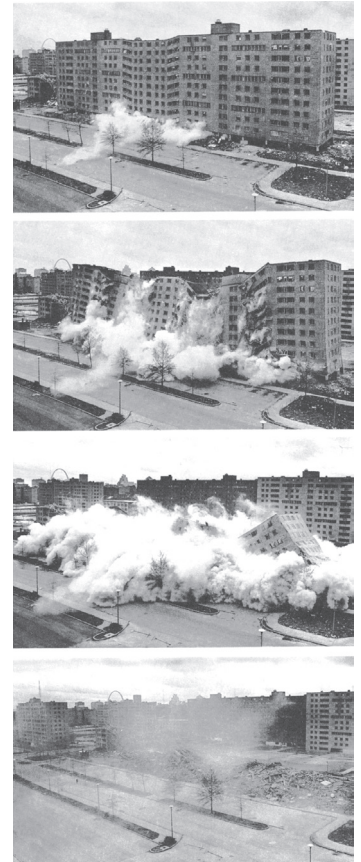
Sprengung einer Großsiedlung
