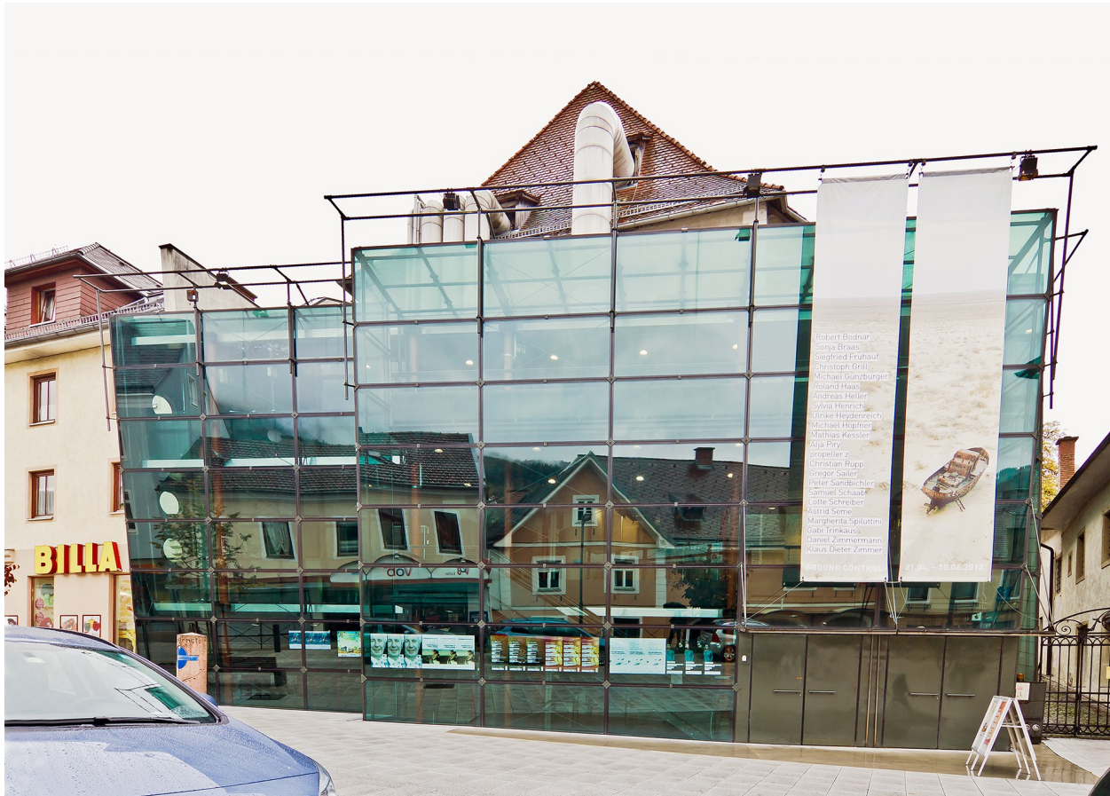
Abb. 3.19 Hauptfassade Kunsthhaus, Mürzzuschlag
