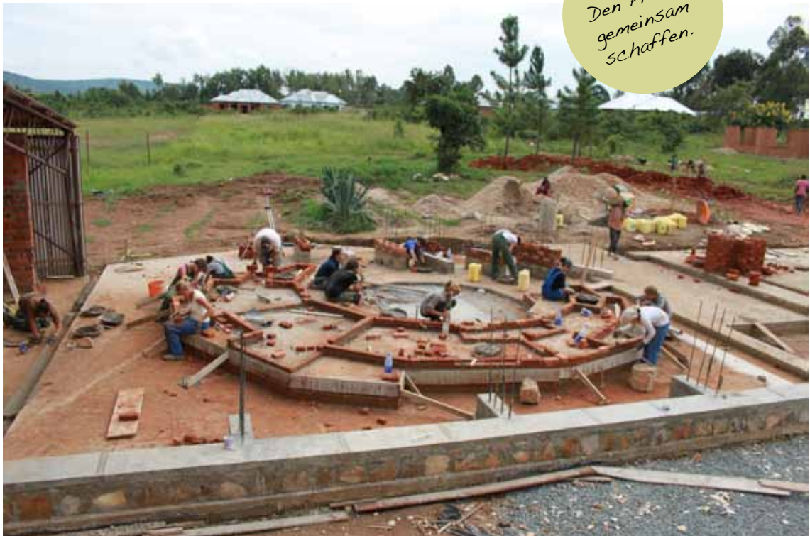
Aufmauern eines Sitzmöbels und Stützen
