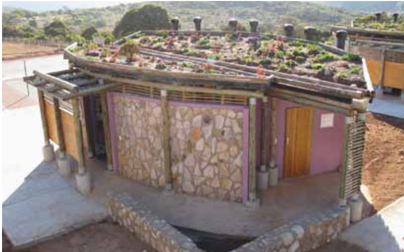
Trockentoilette der Vele School
