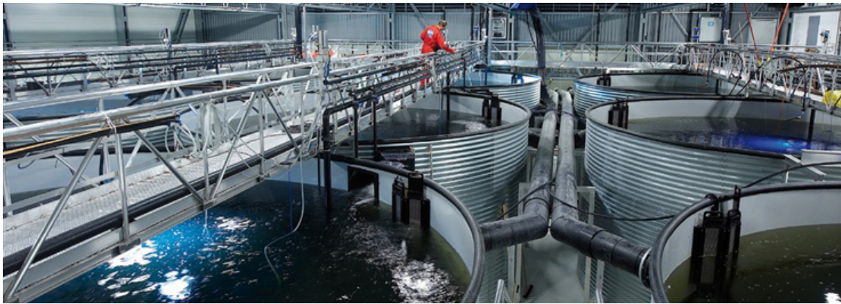
Abb. 38 Indoor-fish-farming mit Kreislaufanlagen
