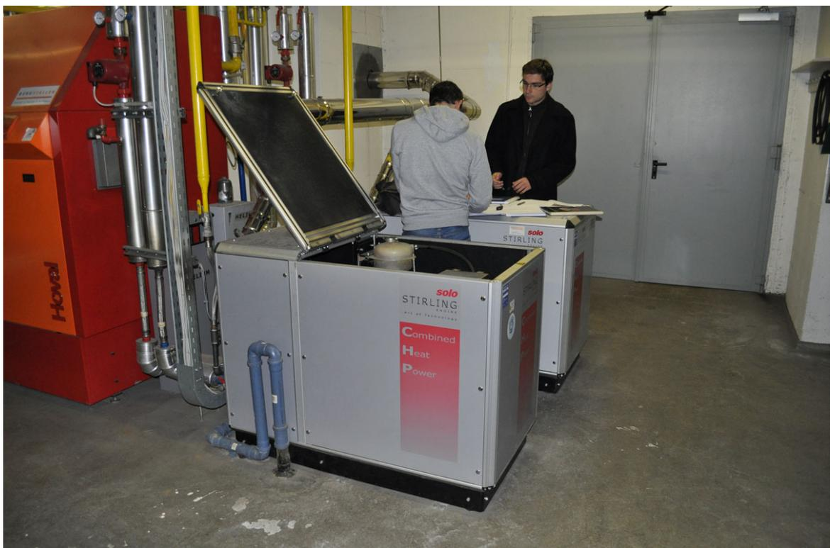
Abbildung 5-17: Besichtigung eines Stirling-BHKW mit zwei SOLO V161 Maschinen im Stukitzbad Andritz
