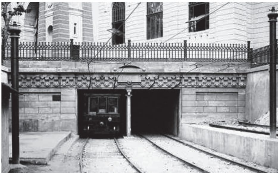
Abb.07: Tunnelportal der U-Bahn 1896
