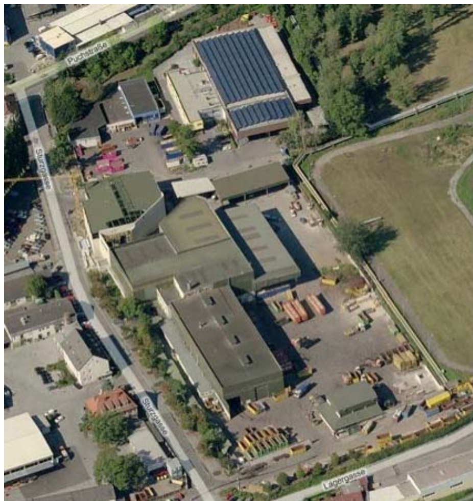
Luftbild Halle Müllsortierung
