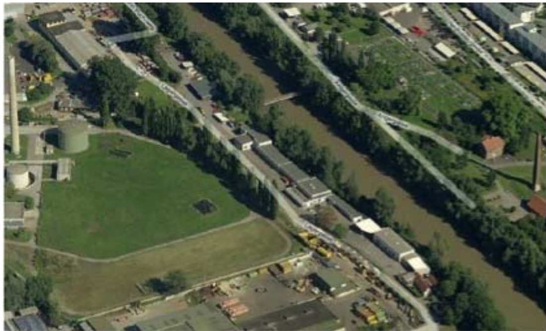
Luftbild Bereich Abwasser, Lagergasse
