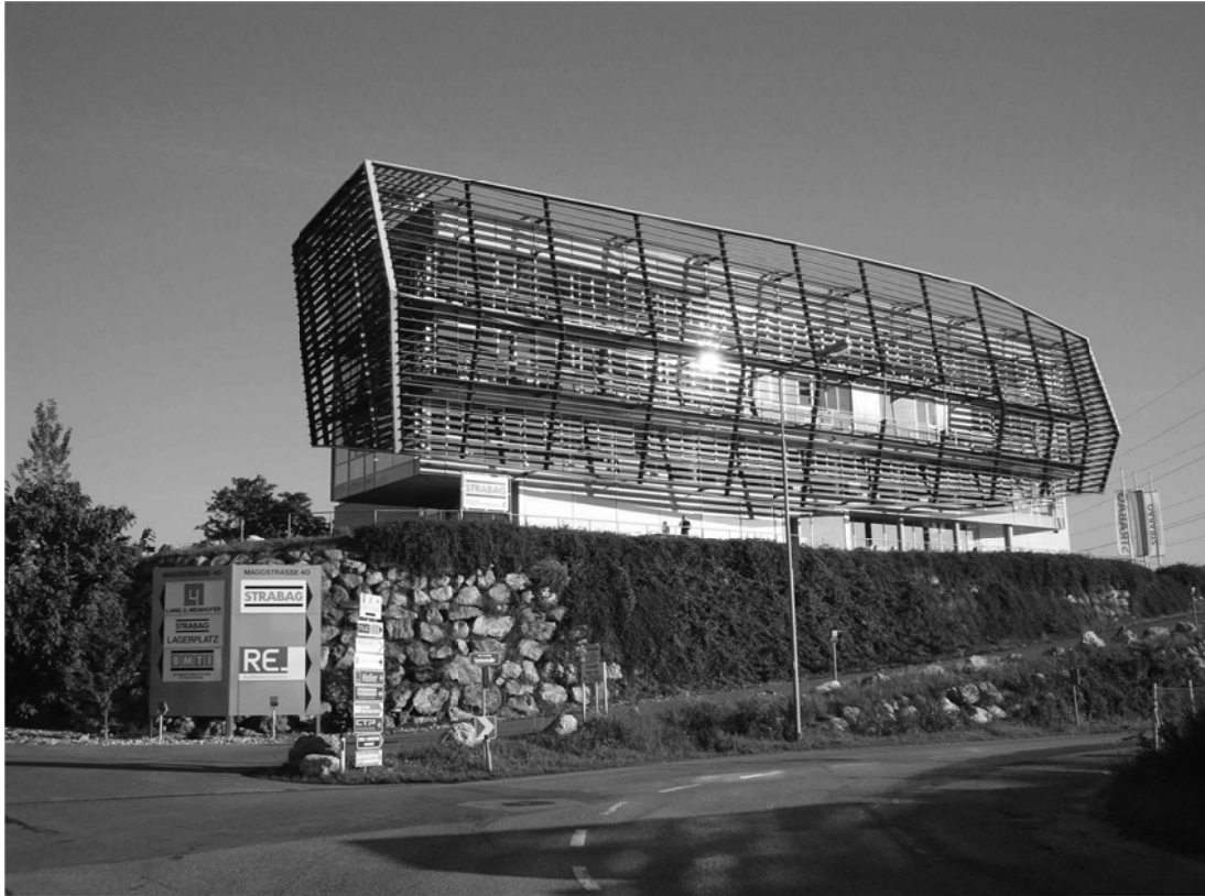
Nachnutzung: Betriebsgebäude auf der ehemaligen Deponie Köglerweg (Foto: Fischer) 3
