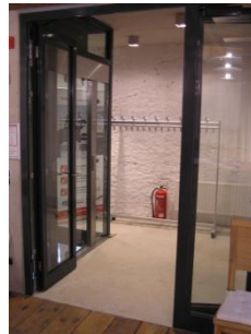
Abbildung 33: Lift im Stiegenhaus ( http://www.burg-rabenstein.at 3.3.2012)
