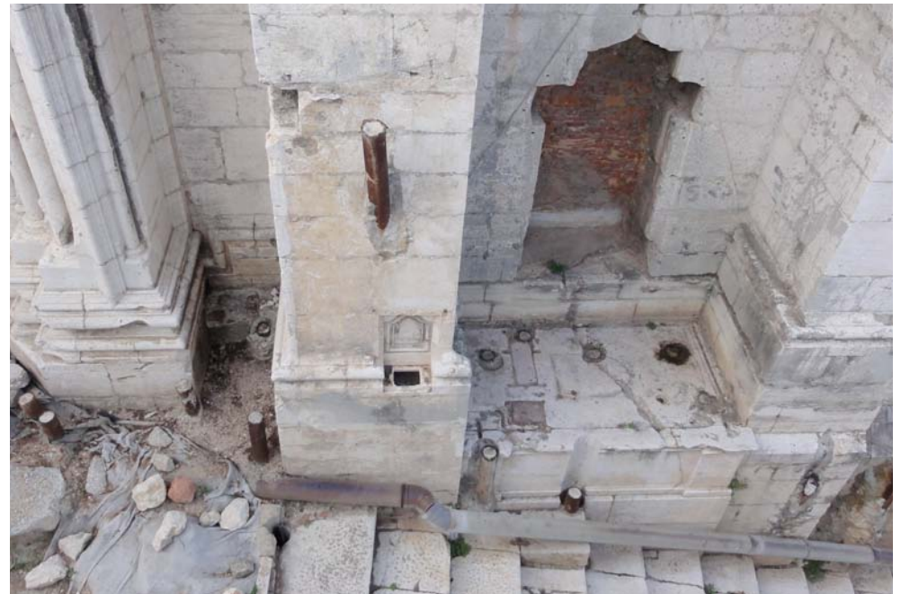
Bohrungen der Fundamentverstärkung neben Südportal Abb. 33
