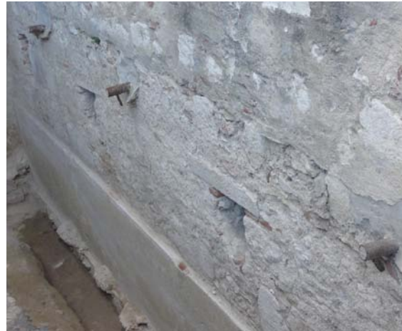
Horizontale Bohrungen der Fundamentverstärkung Abb. 30
