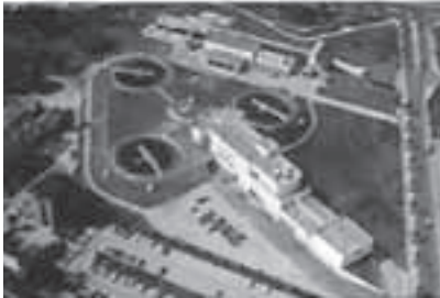
Abb. 20 Phosphateliminierungsanlage in: Kleihues/Becker-Schwering/Kahlfeldt (Hg.), Bauen in Berlin 1900-2000, Berlin 2000, 358.
