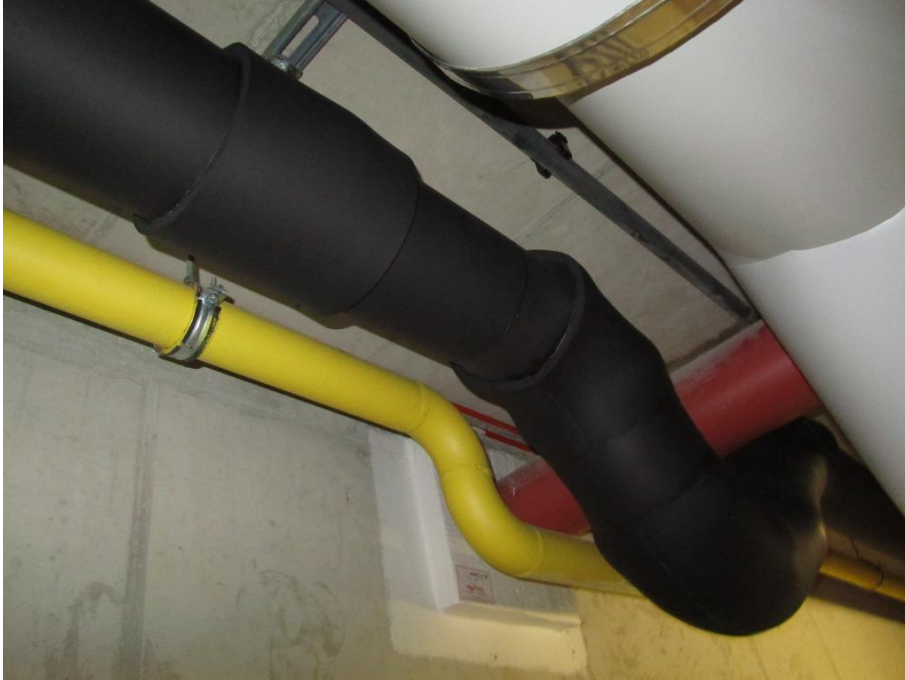
Abbildung 2-1 Kaltwasserisolierung mit Elastomerschaumplatten, Ausführung A
