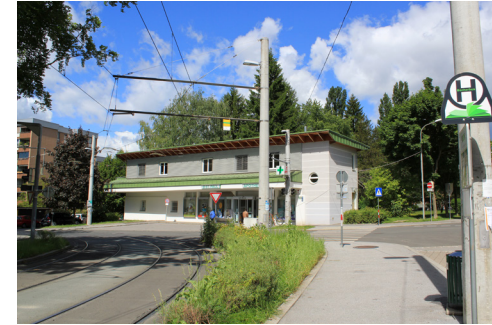
Kreuzungsbereich Eisteichgasse | St. Peter Pfarrweg
