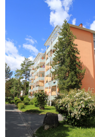
Wohnbau am Fuße des Bauplatzes
